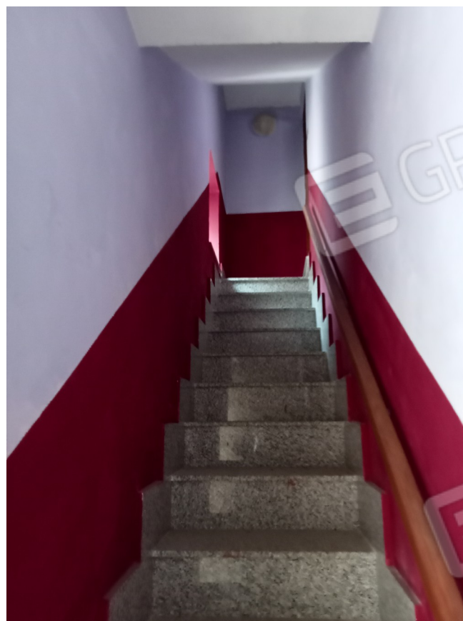
Foto 7: " Corpo scala interno"
