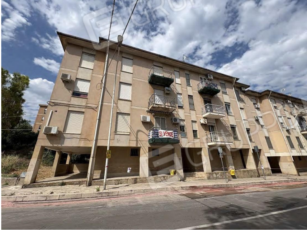
Fotografia 3 – Prospetto angolo via F. Parri n. 8
