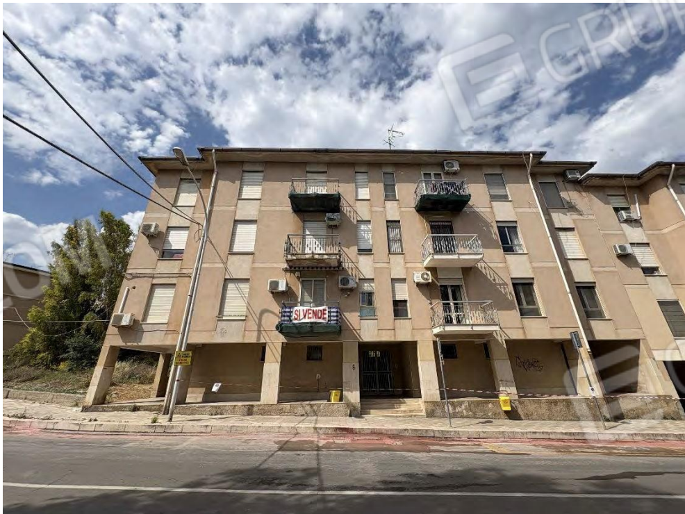
Fotografia 4 – Prospetto frontale via F. Parri n.8
