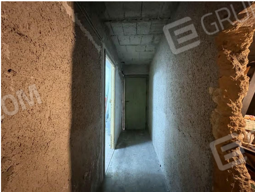
Fotografia 10 – Ingresso magazzino, piano terra, scala D
