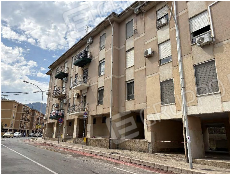
Fotografia 5 – Prospetto angolo via F. Parri n.8
