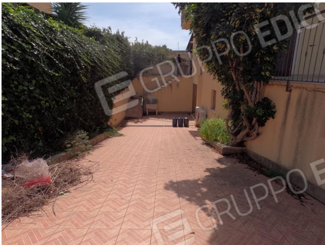
Figura 3. Vista della rampa di accesso al piano cantinato (lato est) e scala di accesso a veranda sul retro
