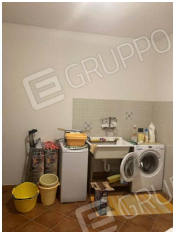
Figura 8. Vista di locale lavanderia realizzato al piano cantinato in assenza di autorizzazione edilizia, foto 2
