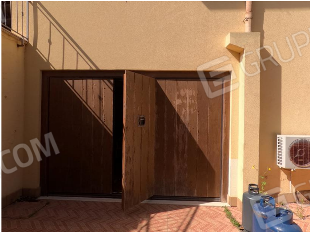
Figura 4. Particolare del portone di accesso al piano cantinato, lato est
