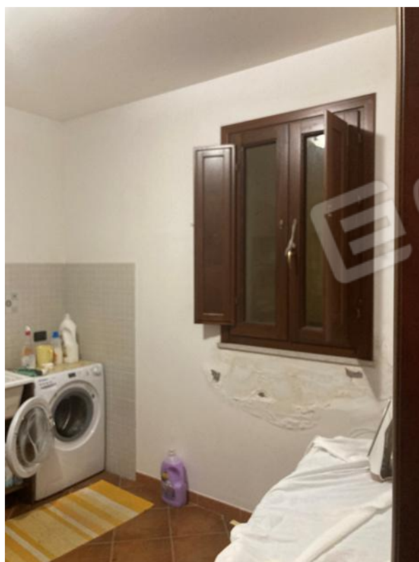
Figura 7. Vista di locale lavanderia realizzato al piano cantinato in assenza di autorizzazione edilizia, foto 1
