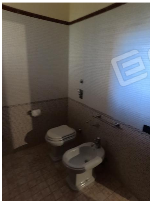
Figura 22. Vista bagno al piano terreno – foto 2
