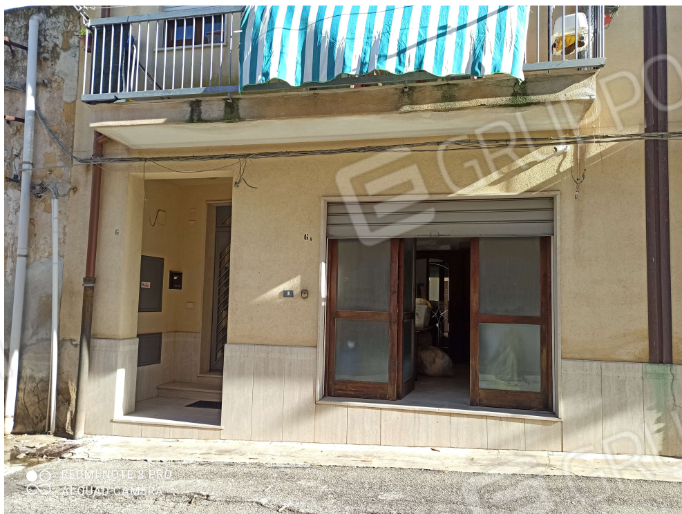
Facciata si via Enea – autorimessa e androne
