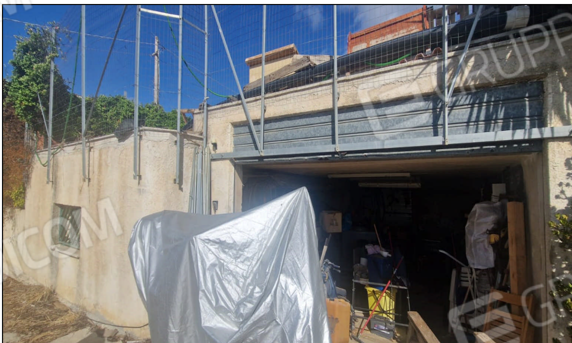
Foto 14: Particolare ingresso “locale Garage” (piano Seminterrato)
