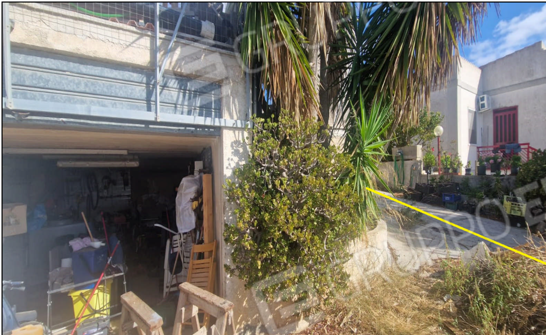
Foto 15: Particolare ingresso “locale Garage” (piano Seminterrato)
