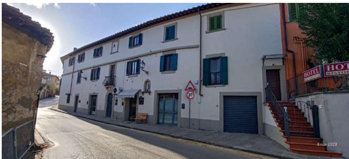
Figura 3 – Particolare immobile da via Jacopo Modesti
