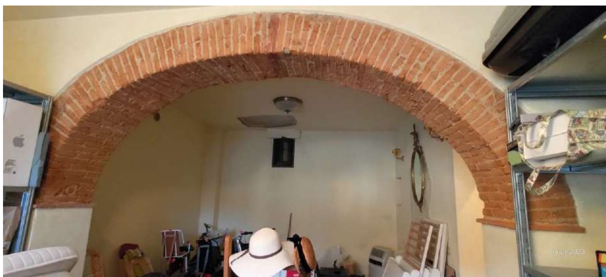
Foto 6 – particolare fondo da ingresso
