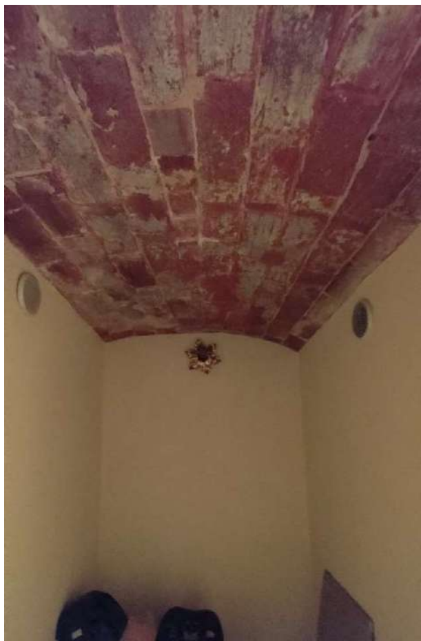
Foto 15 – ripostiglio particolare soffitto
