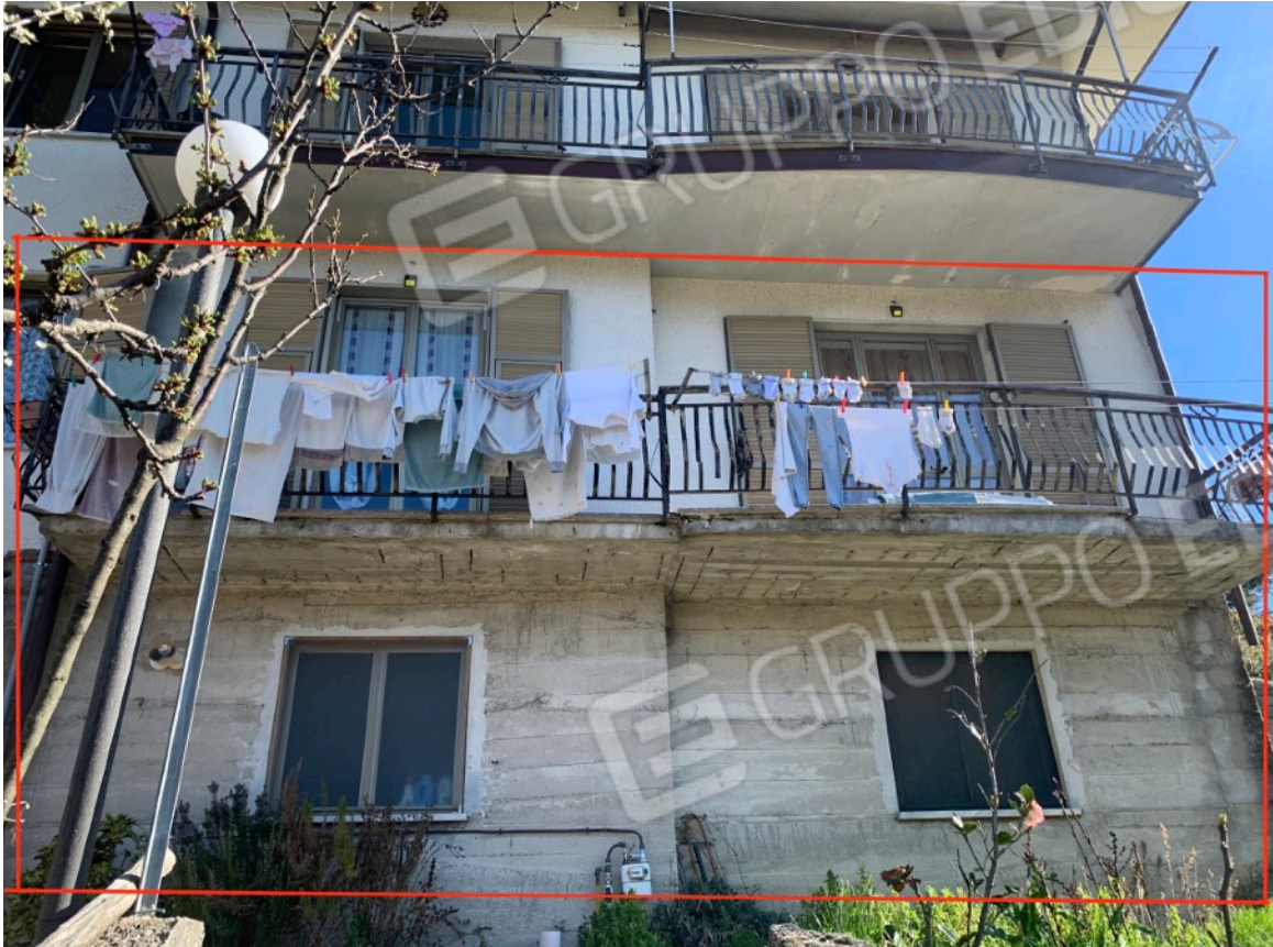
FOTO E6_ fabbricato fronte lato SUD-OVEST
