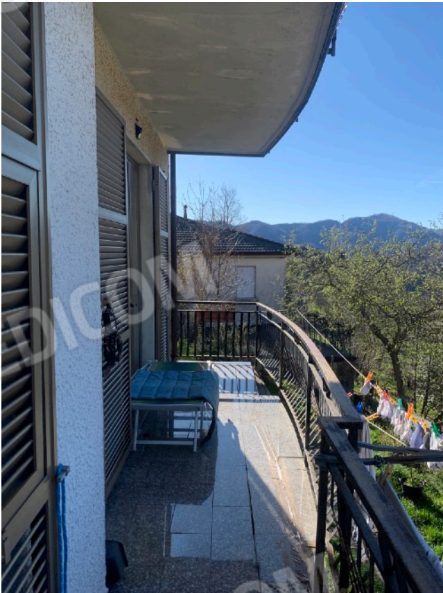
FOTO E7_ Balcone lato fronte SUD-OVEST
