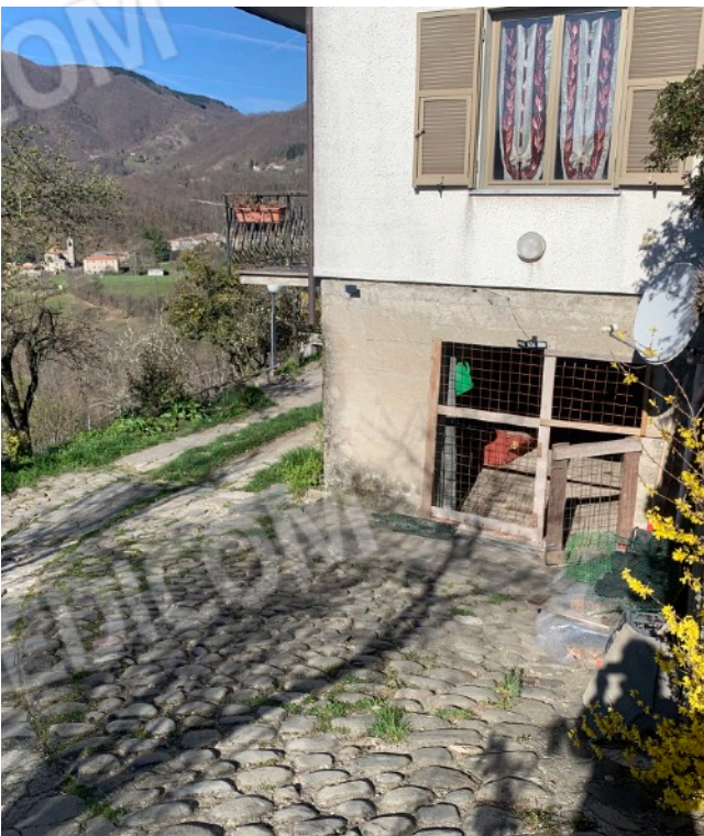
FOTO E4_ fabbricato, locali accessori cantina-deposito lato SUD-EST
