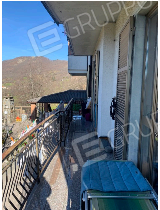
FOTO E8_ Balcone lato fronte SUD-OVEST
