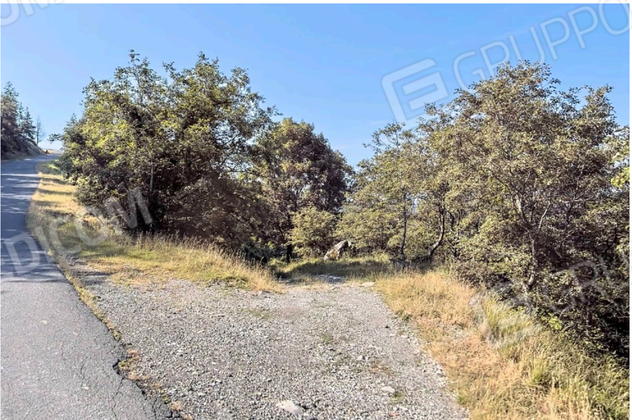
FOTO 4_fabbricato- stalla- part. 527 . Strada poderale di accesso.
