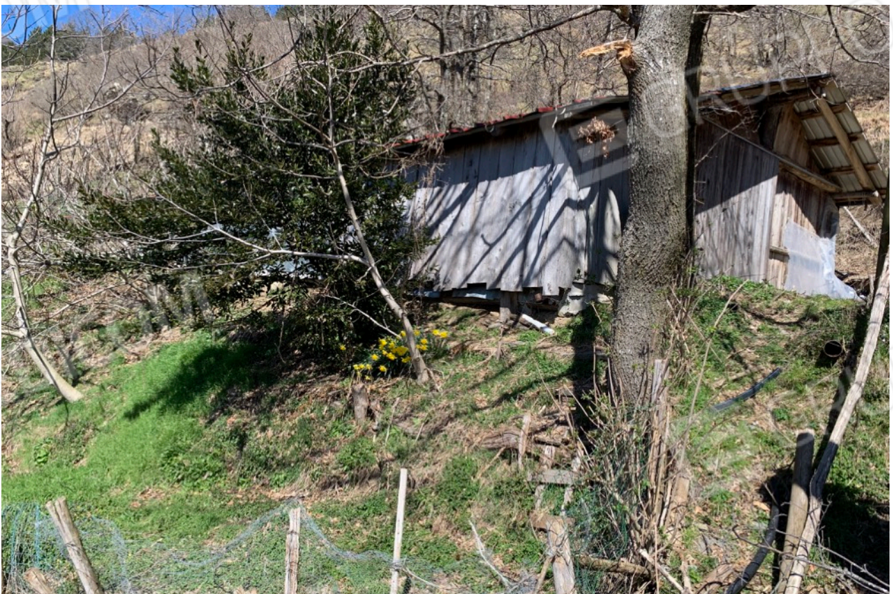
FOTO 2_fabbricato- stalla- part. 527
