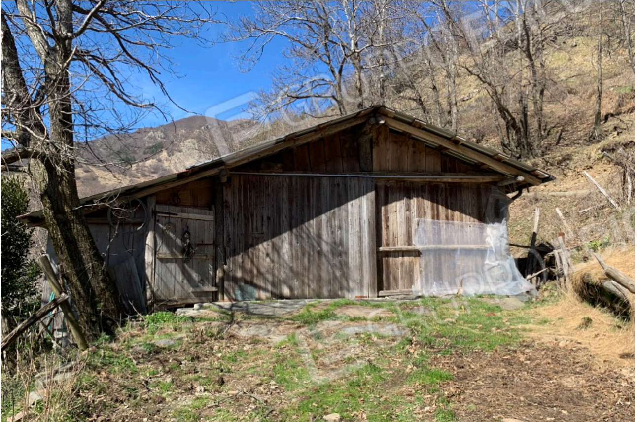
FOTO 1_fabbricato- stalla- part. 527
