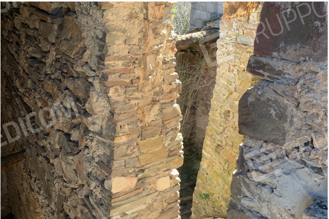
FOTO 4_dettaglio interno Fabb. Rurale part.84
