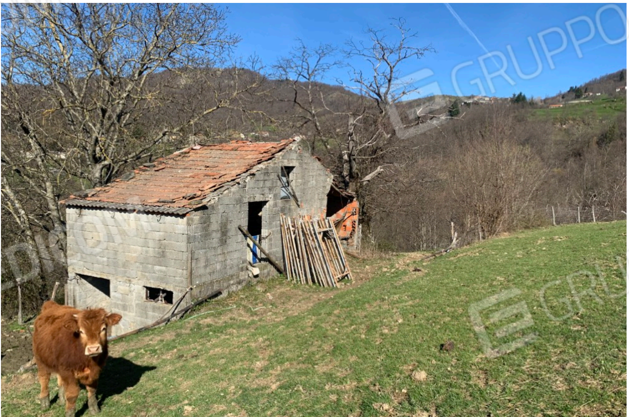
FOTO 4_ Fabb. Rurale e terreno foglio 66, part.138
