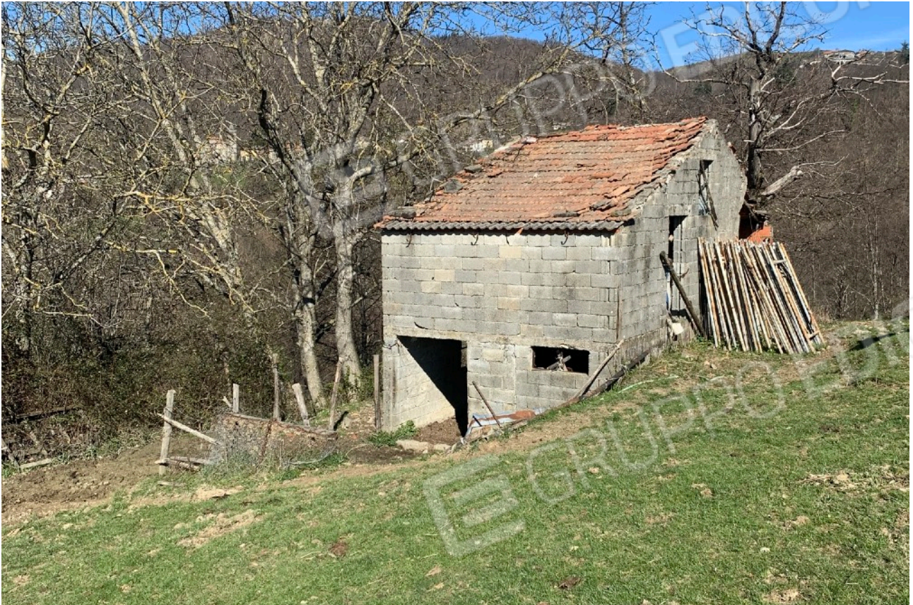
FOTO 3_ Fabb. Rurale e terreno foglio 66, part.138
