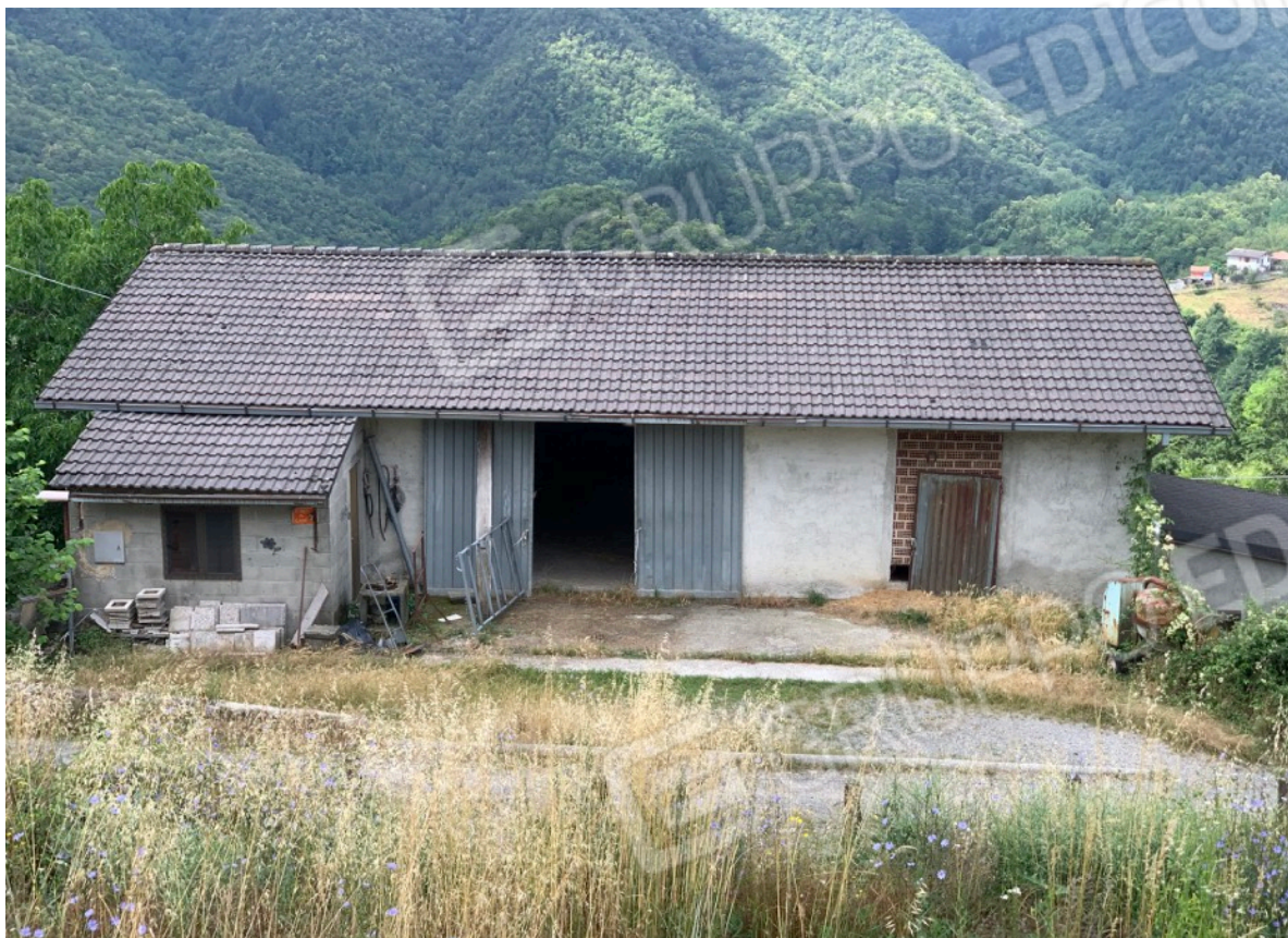
FOTO 7_ Fabb. Agricolo foglio 61, part.841_Fronte Nord-Est
