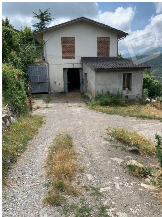
FOTO 10_ Fabb. Agricolo foglio 61, part.841_Fronte Nord-Ovest
