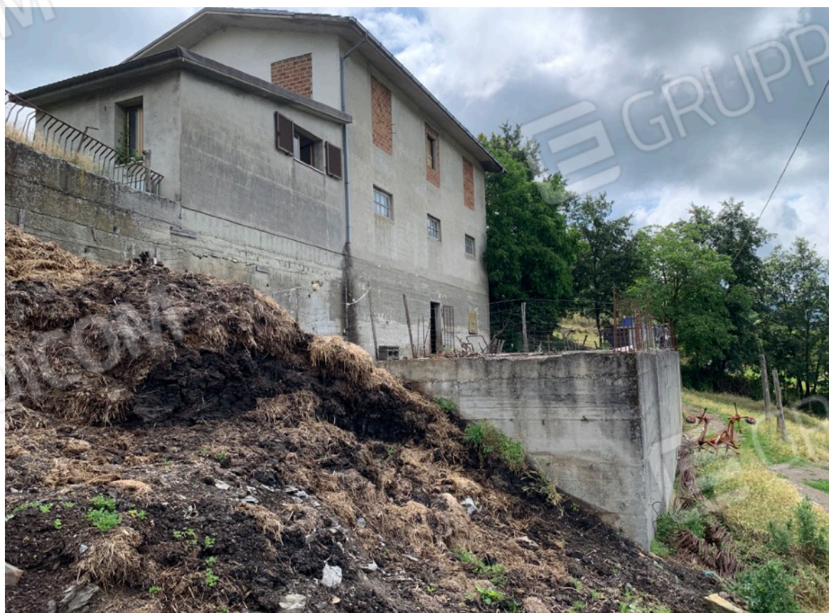
Didascalìa FOTO 8_ Fabb. Agricolo foglio 61, part.841_Fronte Sud-Ovest
