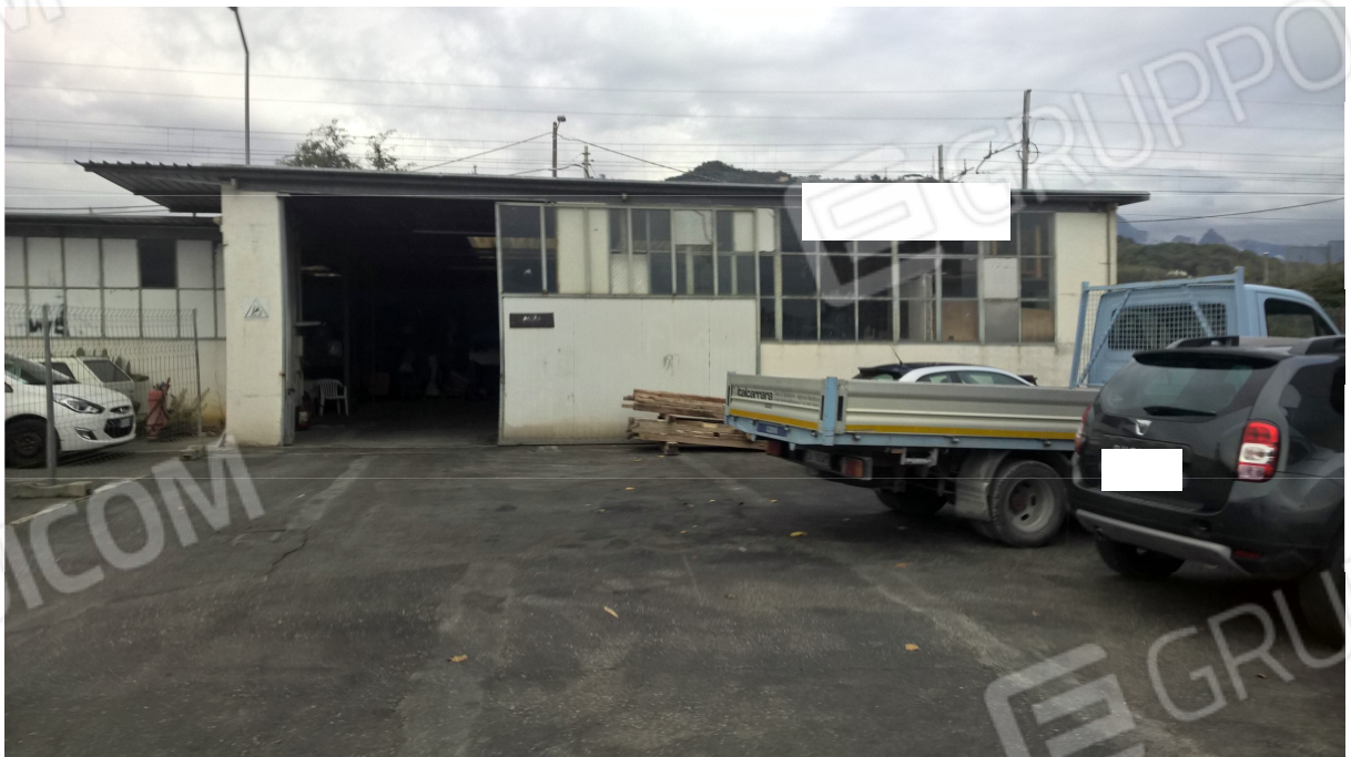
Il capannone – la porzione più alta, verso “Toscana”
