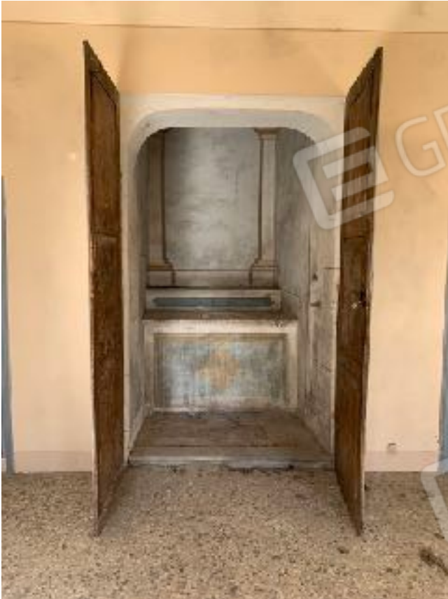
FOTO 4 INTERNO fabbricato part. 214 sub. 2
