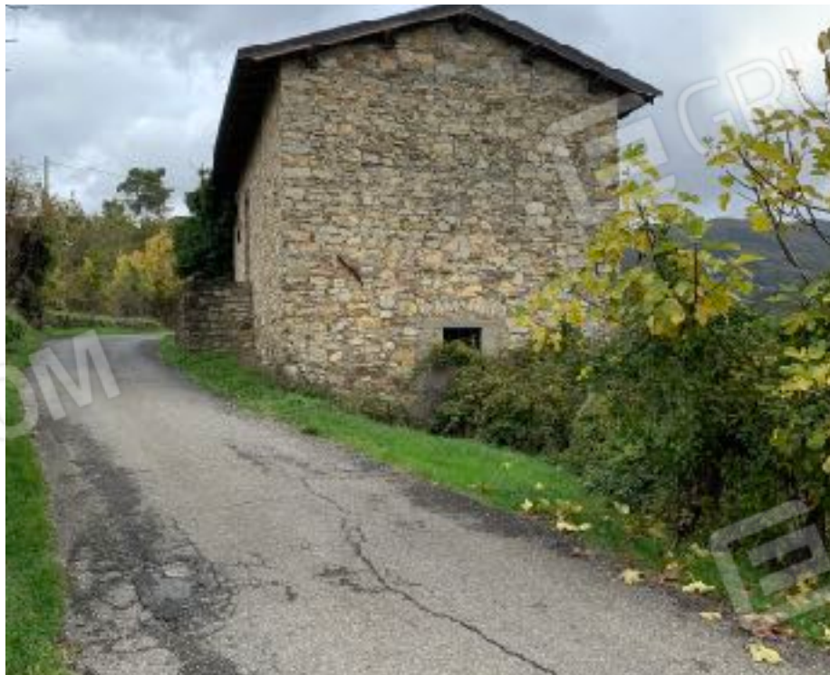
FOTO E5 fabbricato par.213 sub. 1 (piano terra) e 2 (piano primo) fronte SU, SUD-OVEST lungo via comunale di Rottigliana.
