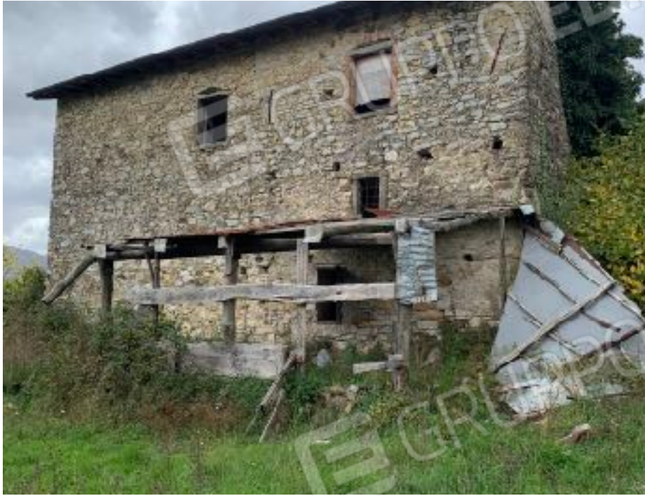
FOTO E5 fabbricato par.213 sub. 1 (piano terra) e 2 (piano primo) fronte EST
