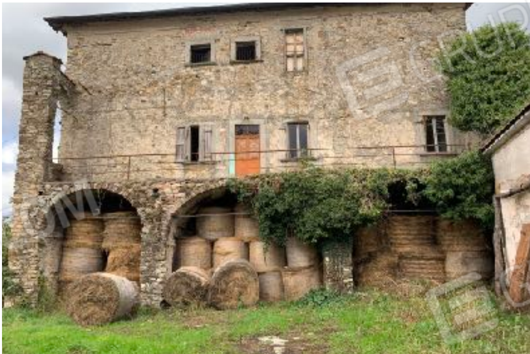
FOTO E2 fabbricato part. 214 sub. 2 fronte principale lato SUD
