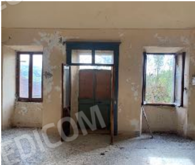
FOTO 2 INTERNO fabbricato part. 214 sub. 2
