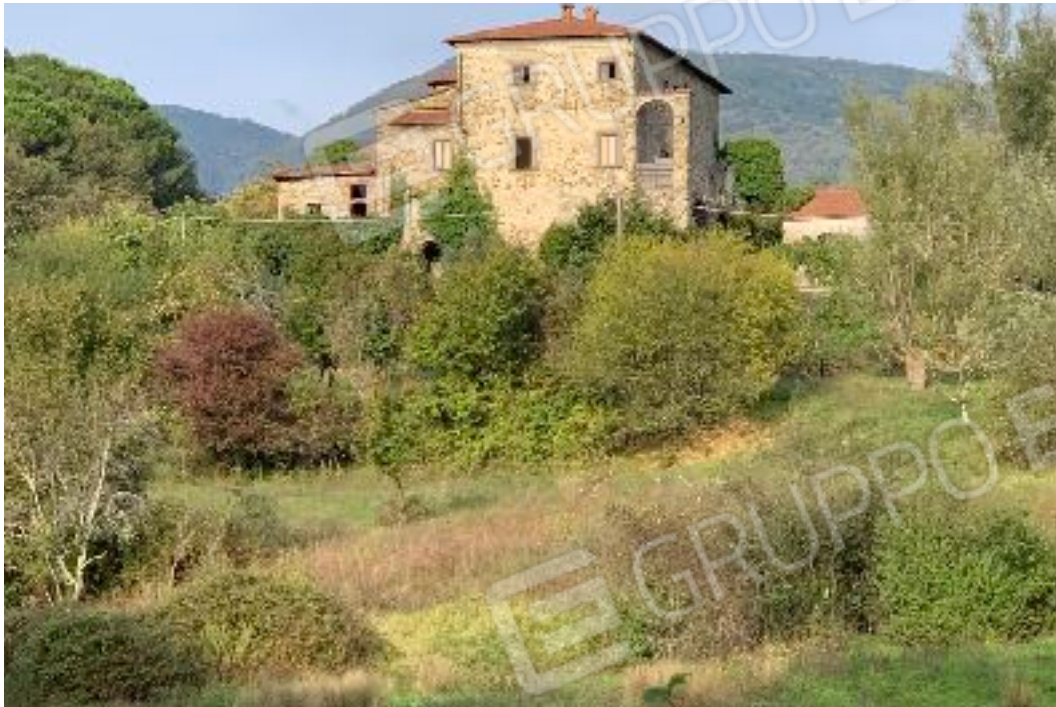
FOTO E1 fabbricati lato OVEST (edifici part 214 sub. 1 e 2)
