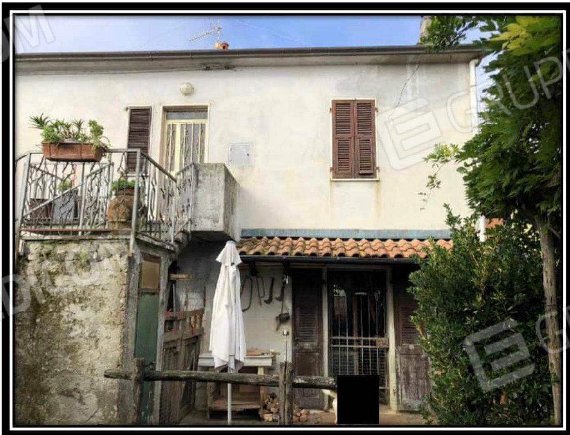
Foto 4 - Porta di uscita secondaria dal retro
