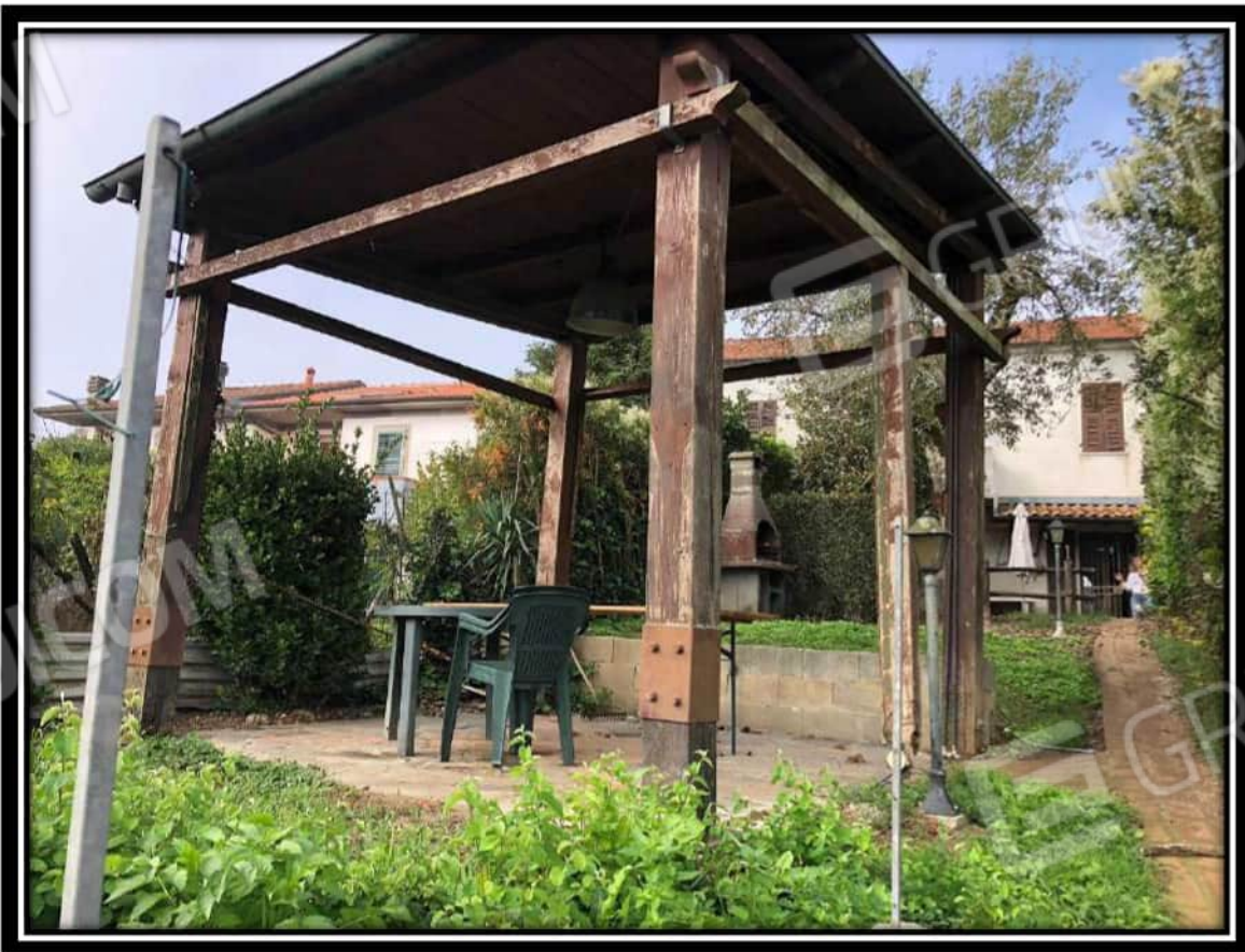
Foto 29 – Terrreno mappale 902 – Tettoia
