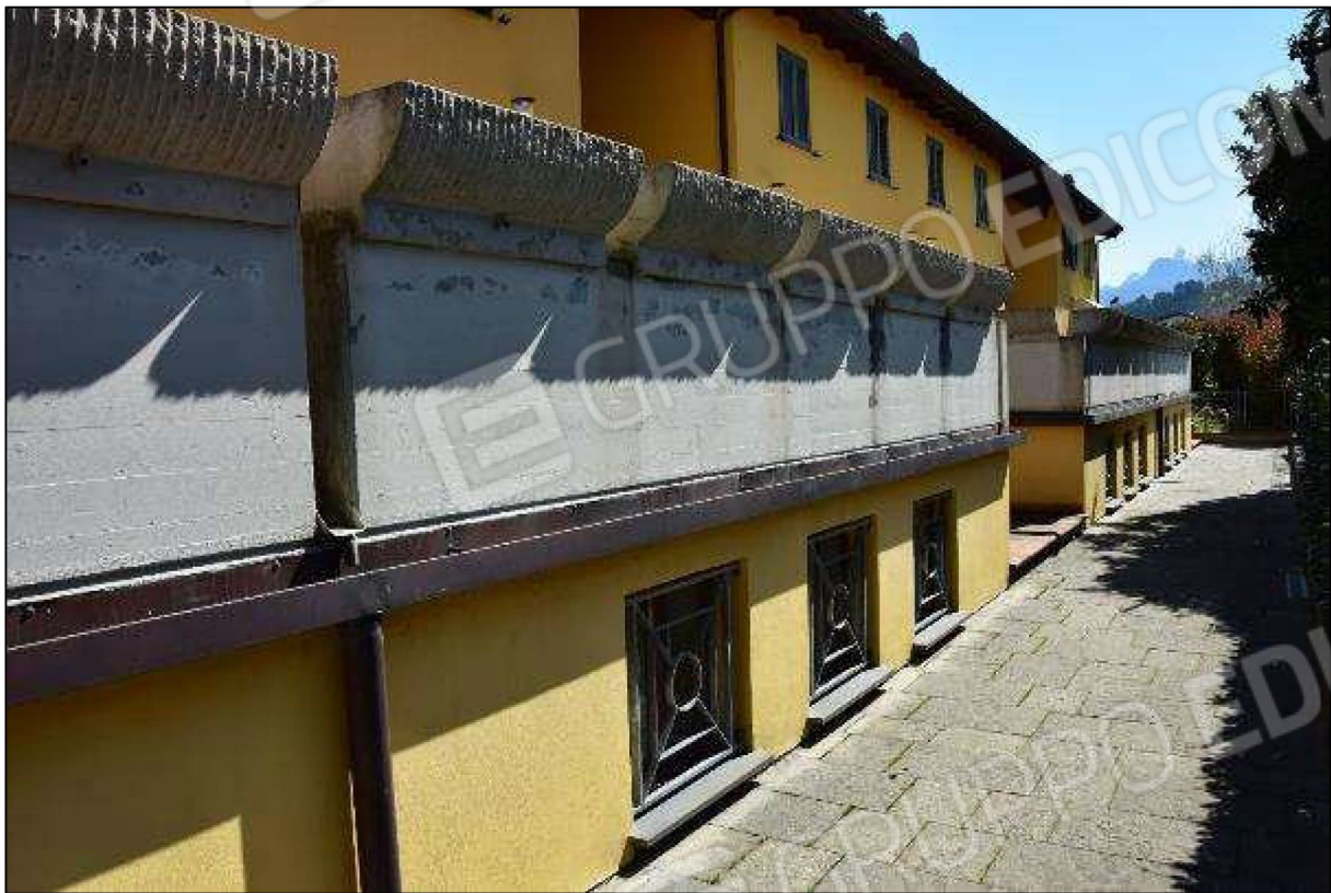
FOTO 10 – FINESTRE PIANO SEMINTERRATO
