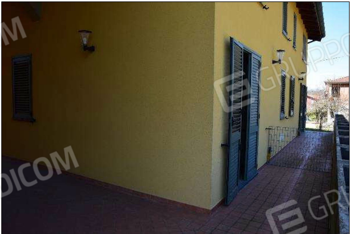
FOTO 15 - TERRAZZA LATO NORD-EST
