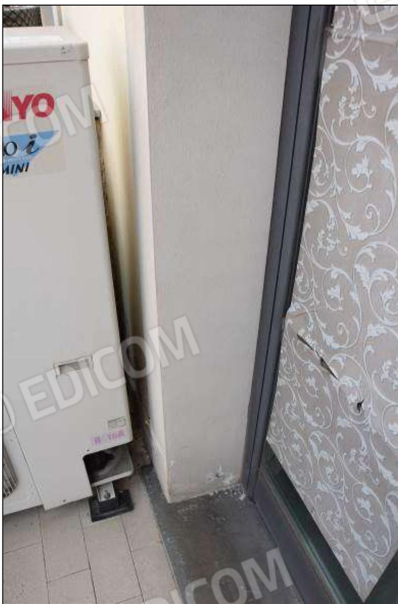
FOTO 11 – infiltrazione di umidità
