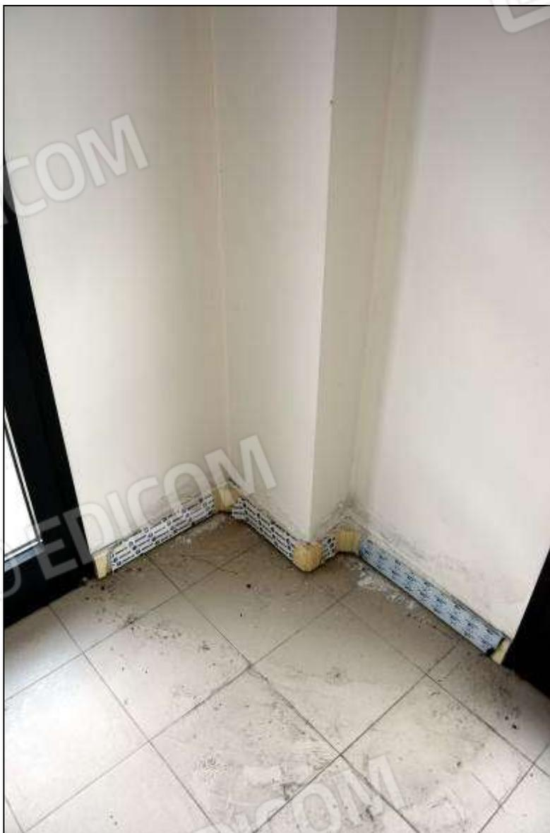
**FOTO 11 – infiltrazioni di umidità**
