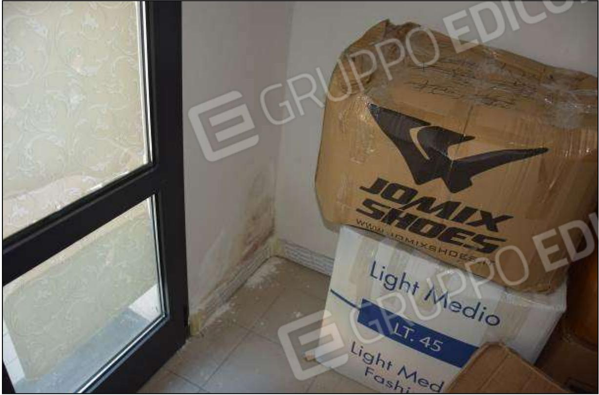
FOTO 13 – infiltrazione di umidità proveniente dalla terrazza
