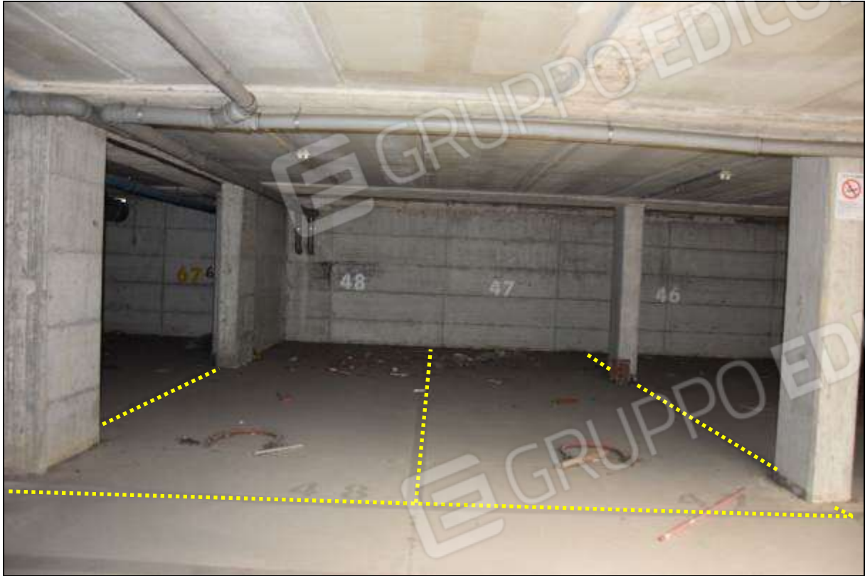
FOTO 1 – SUB 102 (POSTO 48) / SUB 103 (POSTO 47)
