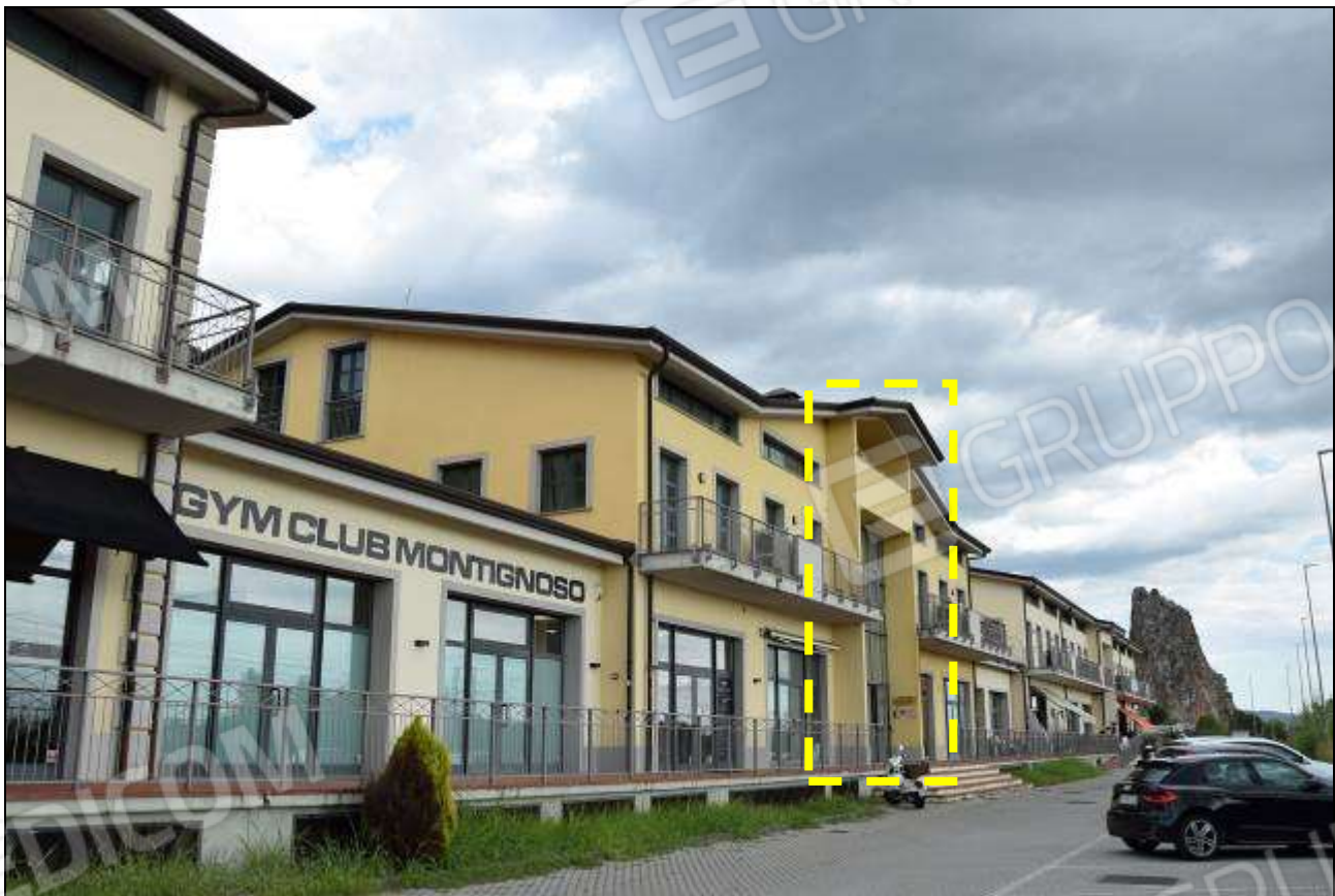
INDIVIDUAZIONE ACCESSO VANO SCALA “B” (BLOCCO CENTRALE)
