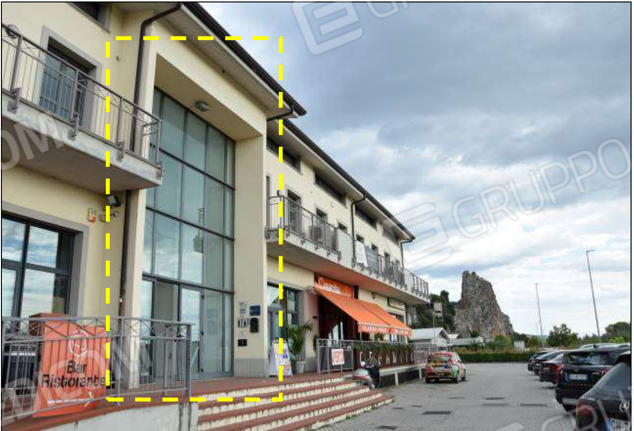
INDIVIDUAZIONE ACCESSO VANO SCALA "C" (BLOCCO DESTRO LATO VIAREGGIO)
