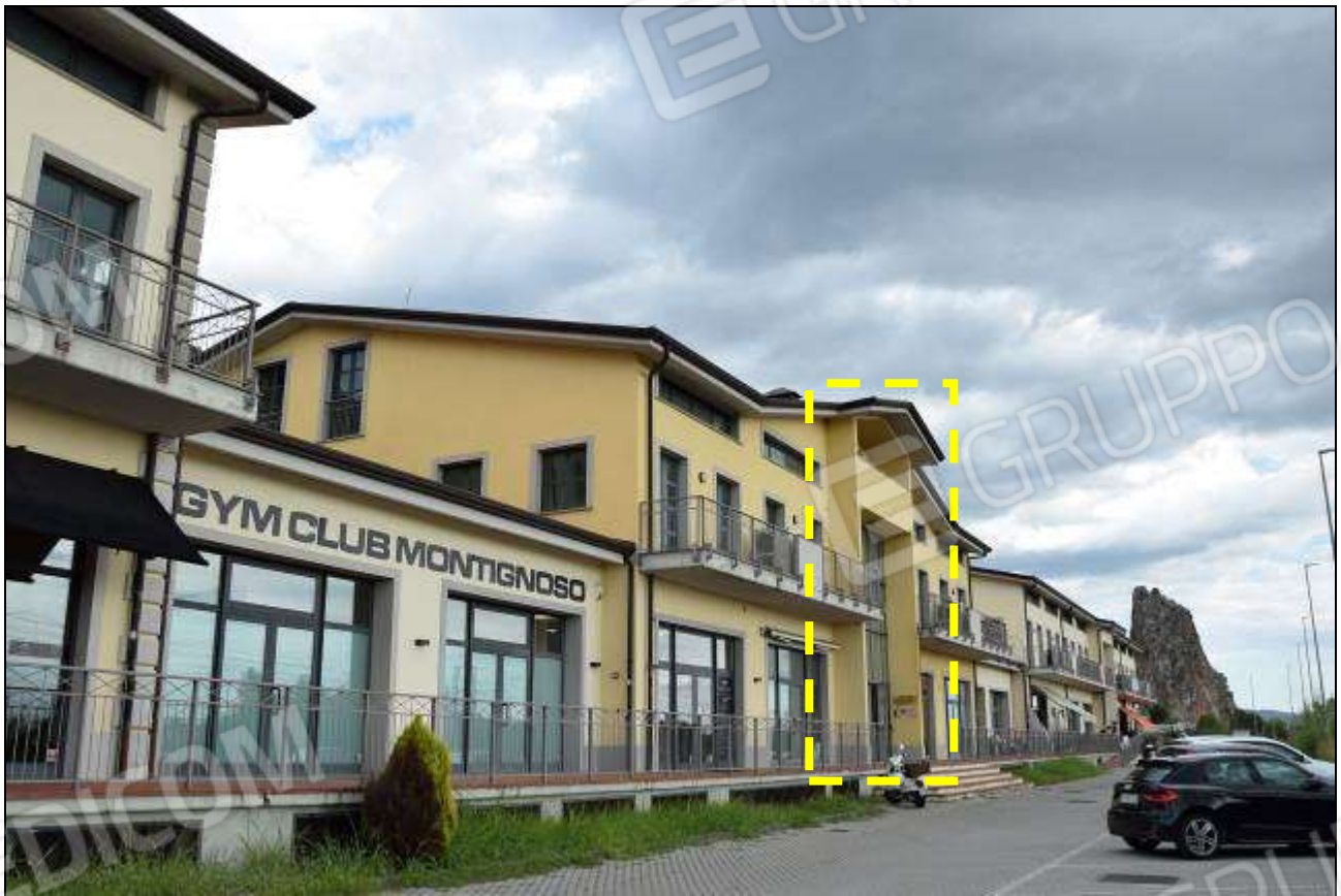
INDIVIDUAZIONE ACCESSO VANO SCALA “B” (BLOCCO CENTRALE)
