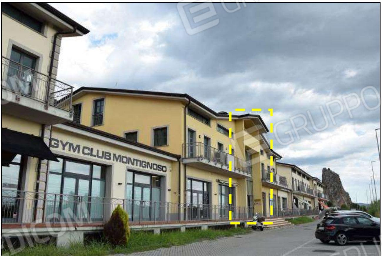
INDIVIDUAZIONE ACCESSO VANO SCALA “B” (BLOCCO CENTRALE)
