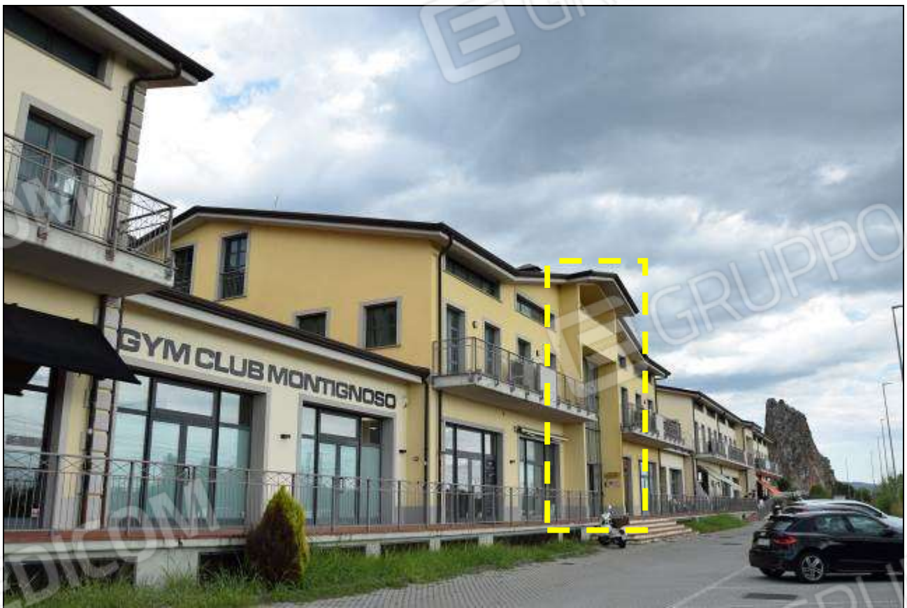
INDIVIDUAZIONE ACCESSO VANO SCALA “B” (BLOCCO CENTRALE)
