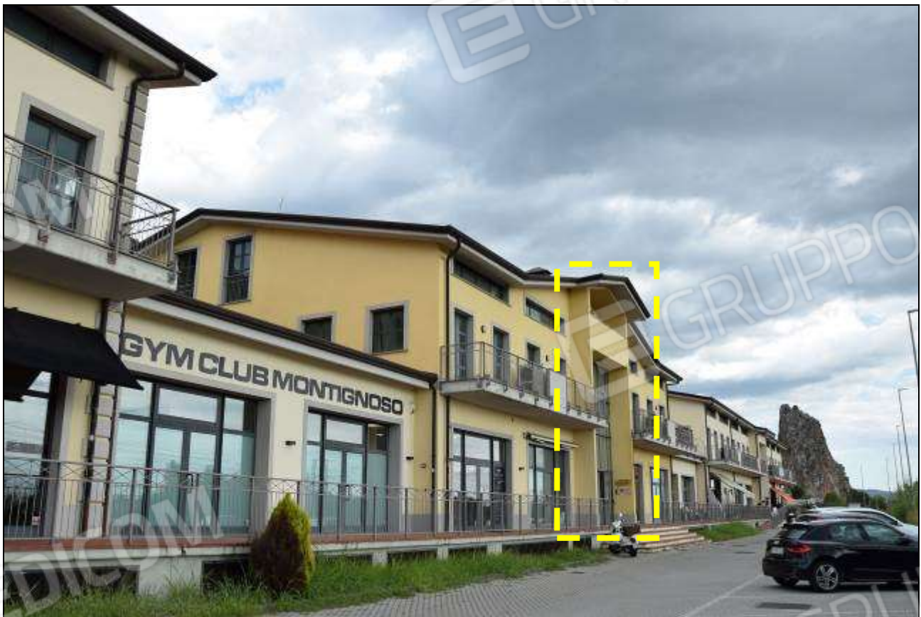
INDIVIDUAZIONE ACCESSO VANO SCALA “B” (BLOCCO CENTRALE)
