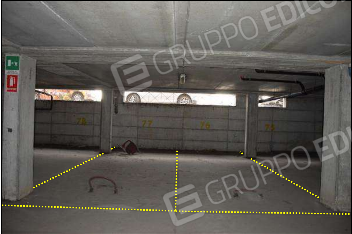
FOTO 1 – SUB 91 (POSTO 77) / SUB 92 (POSTO 76)
