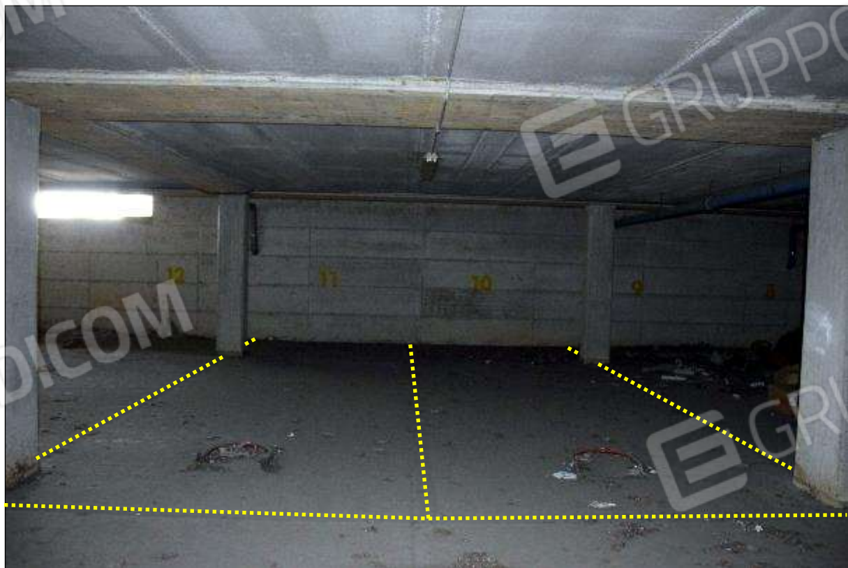
FOTO 14 – SUB 121 (POSTO 11) / SUB 122 (POSTO 10)
