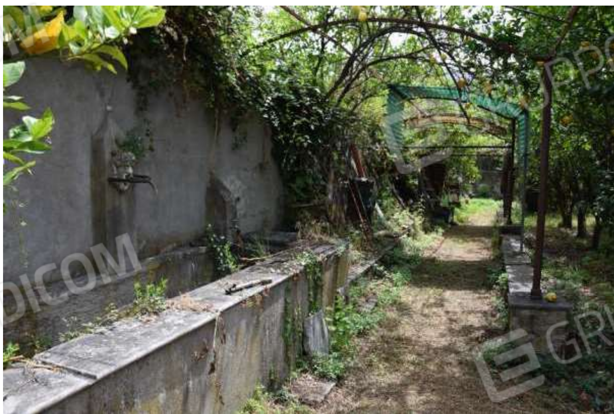
FOTO 24 – Vasca in muratura
