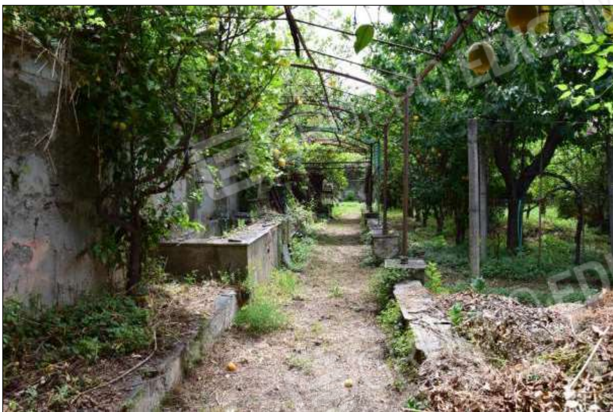
FOTO 23 – pergolato in ferro
