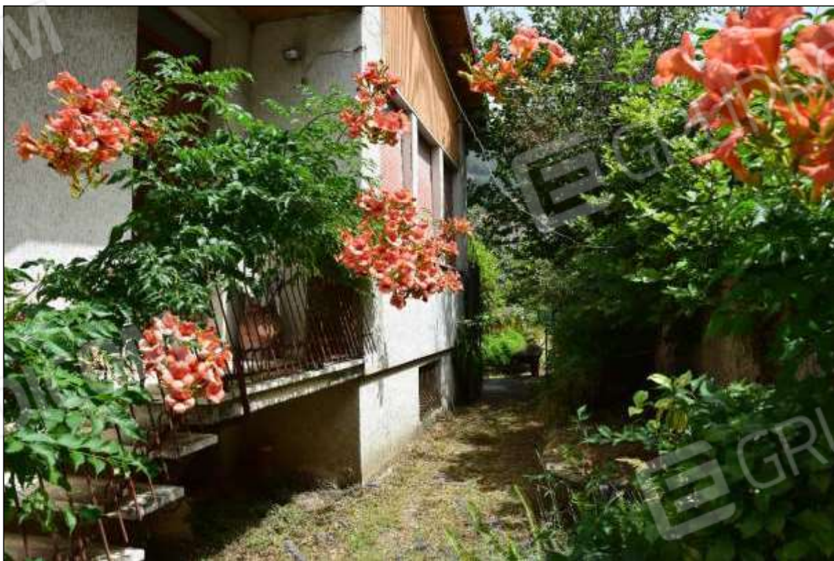
FOTO 4 - Immobile 1 -facciata Sud-Est
