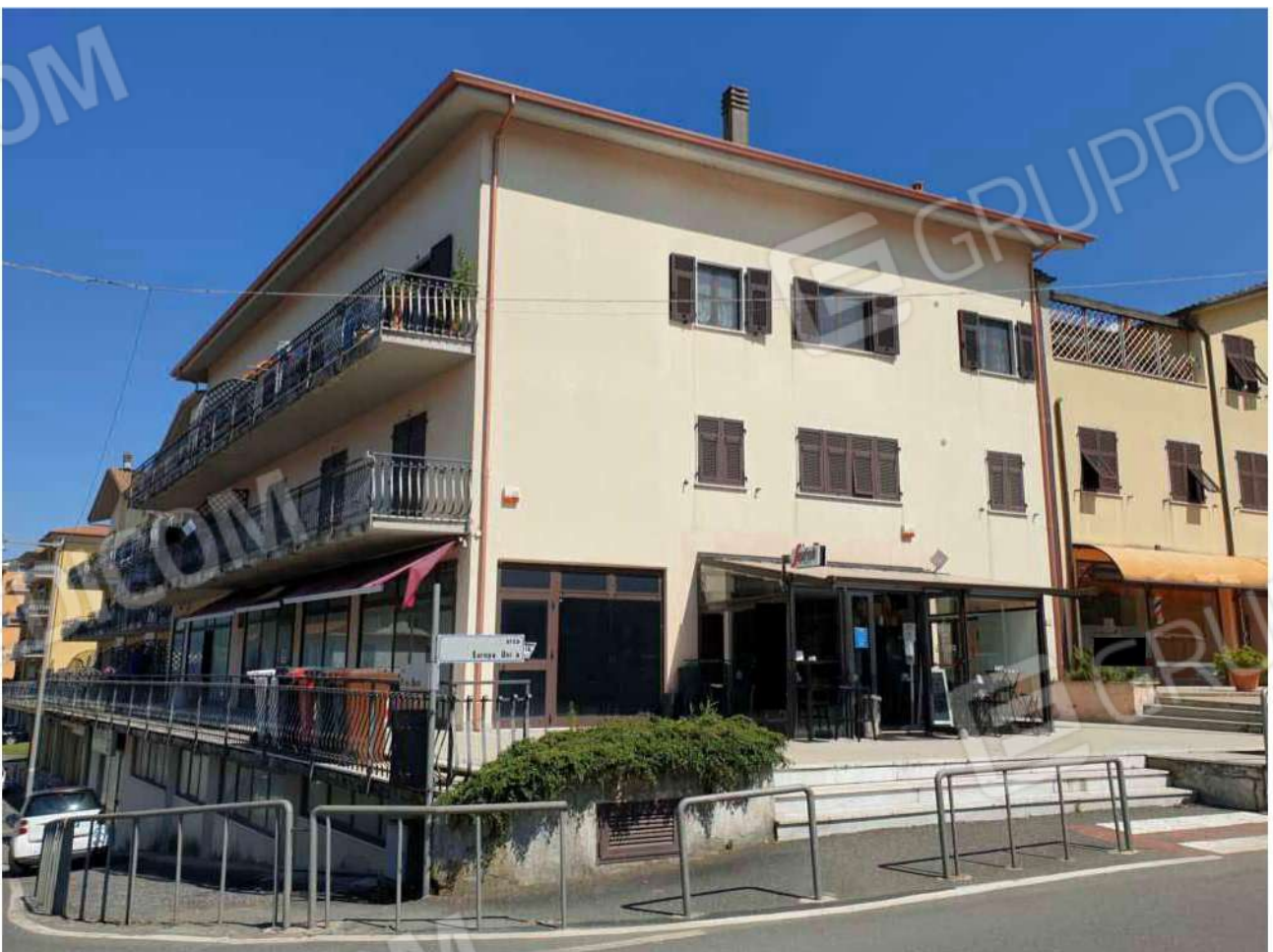
Foto 21. Esterno del condominio
