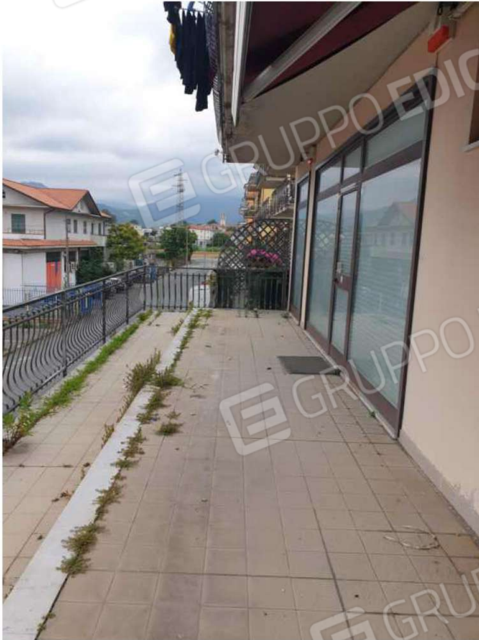
Foto 30. Pertinenza esterna lato via Paesi Bassi e secondo ingresso all'ufficio.
