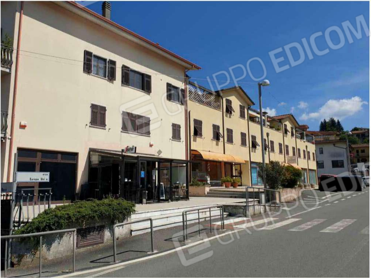
Foto 22. Esterno del condominio
