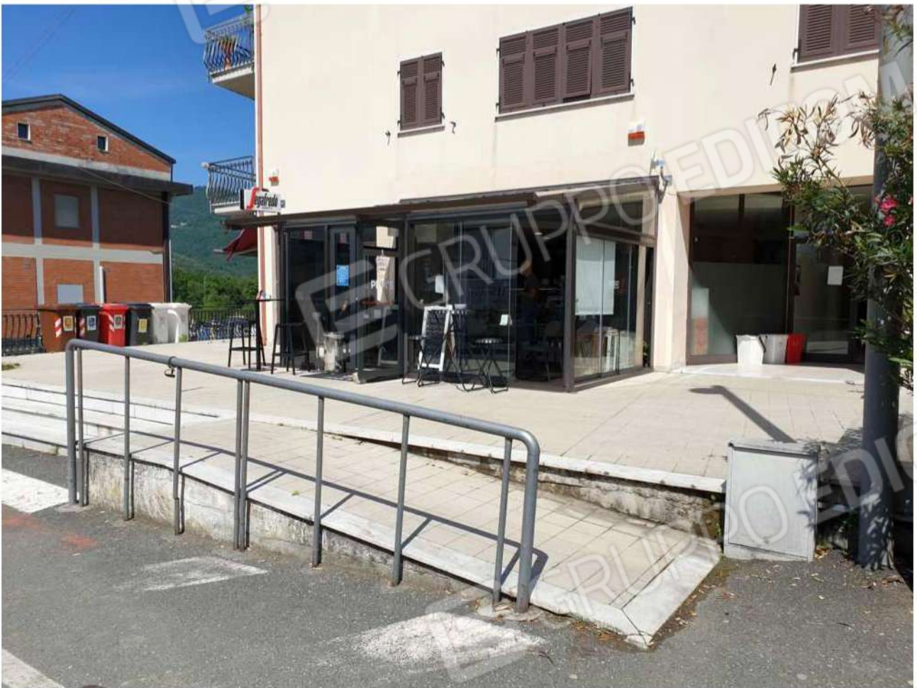
Foto 20. Esterno del condominio
