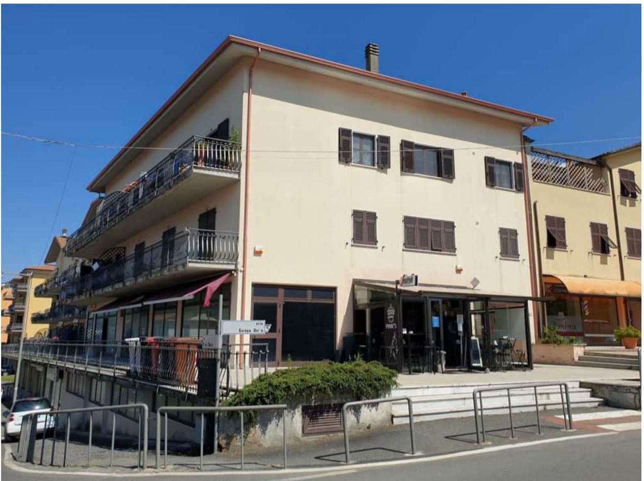
Foto 21. Esterno del condominio
