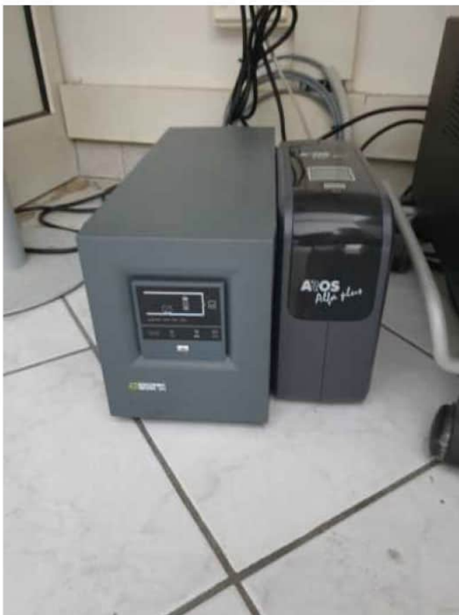
Foto 21. Ufficio 1, gruppo di continuità Socomec Sicon e Aros Alfa plus
