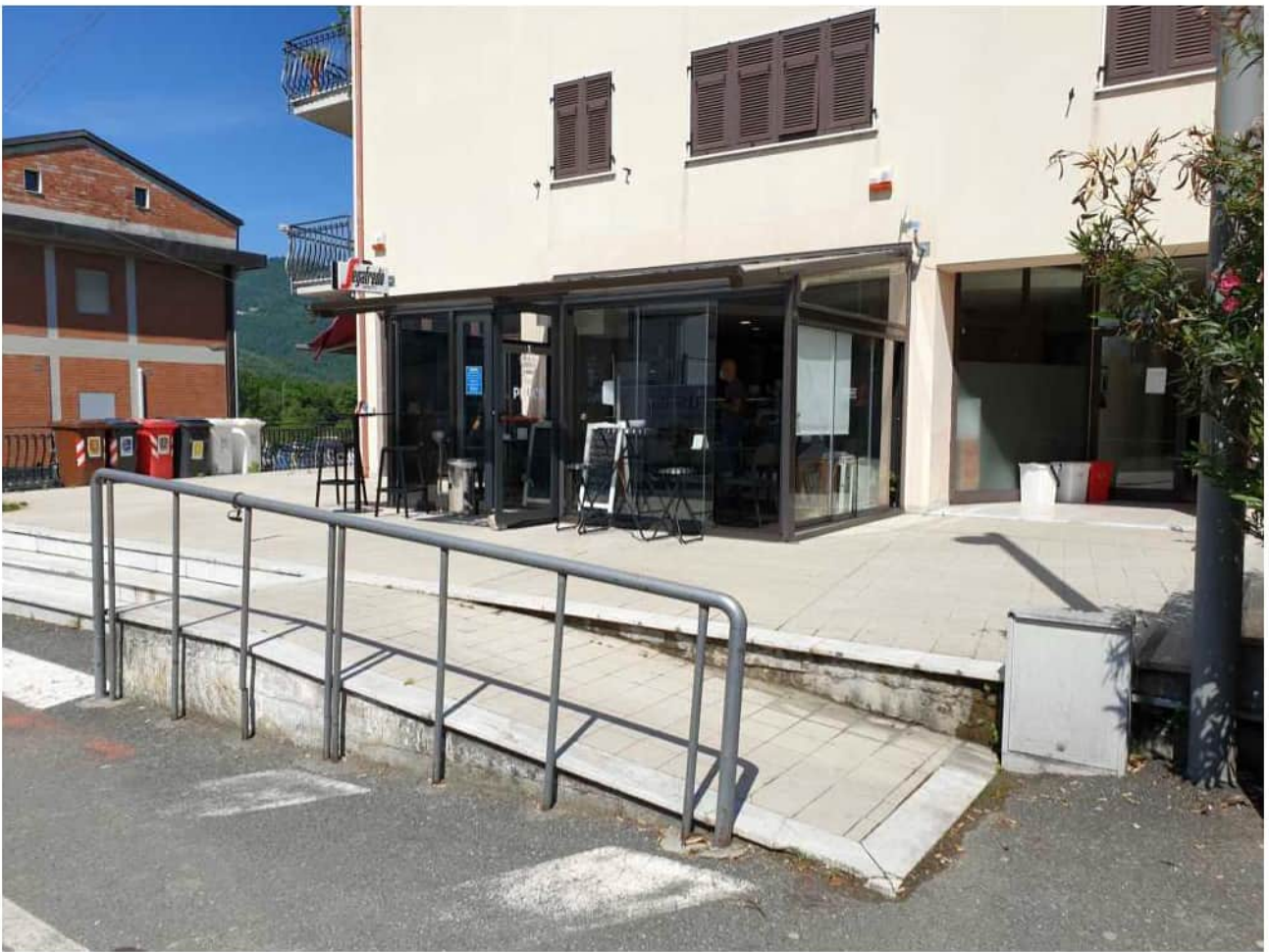
Foto 20. Esterno del condominio
