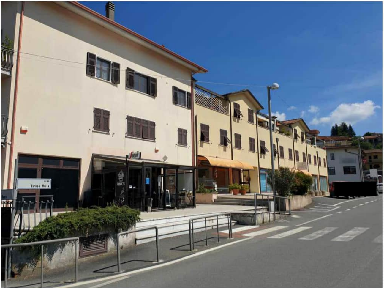
Foto 22. Esterno del condominio
