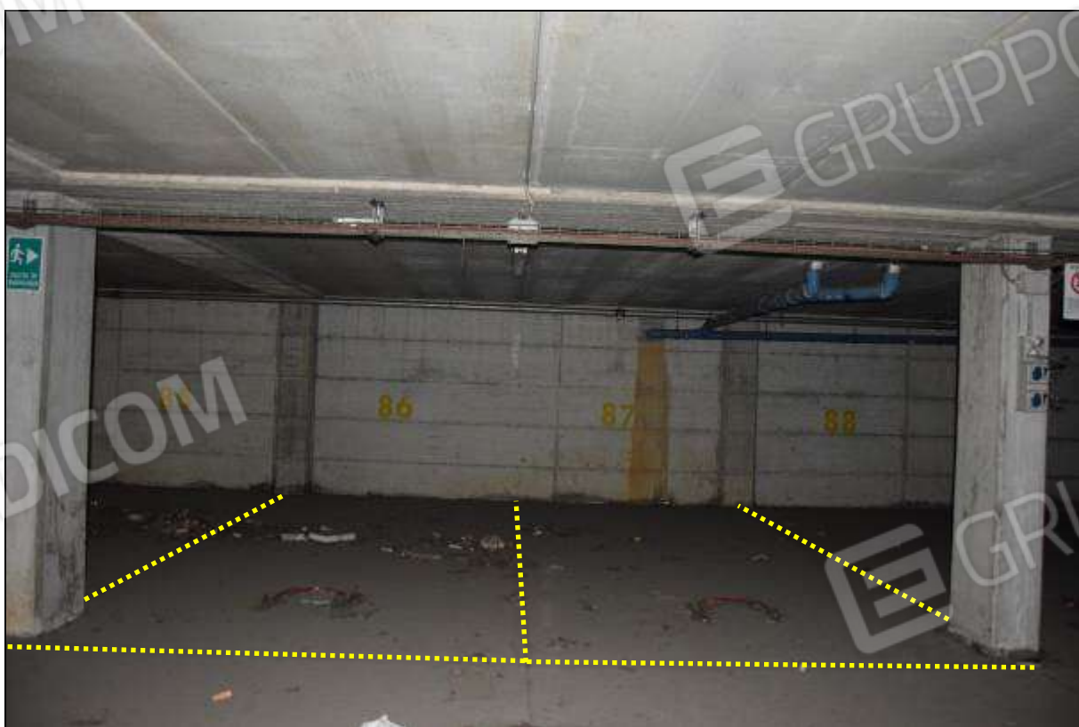
FOTO 4 – SUB 73 (POSTO 86) / SUB 74 (POSTO 87)
