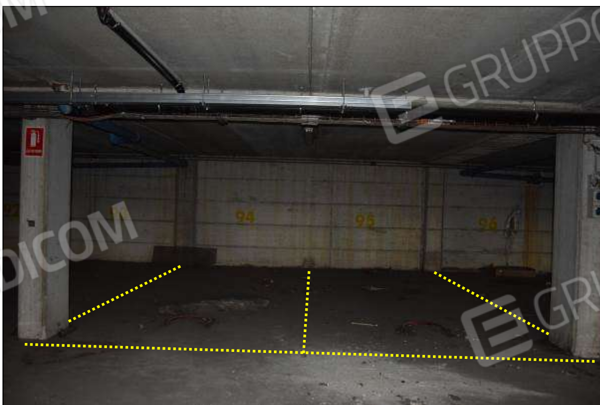
FOTO 8 – SUB 81 (POSTO 94) / SUB 82 (POSTO 95)
