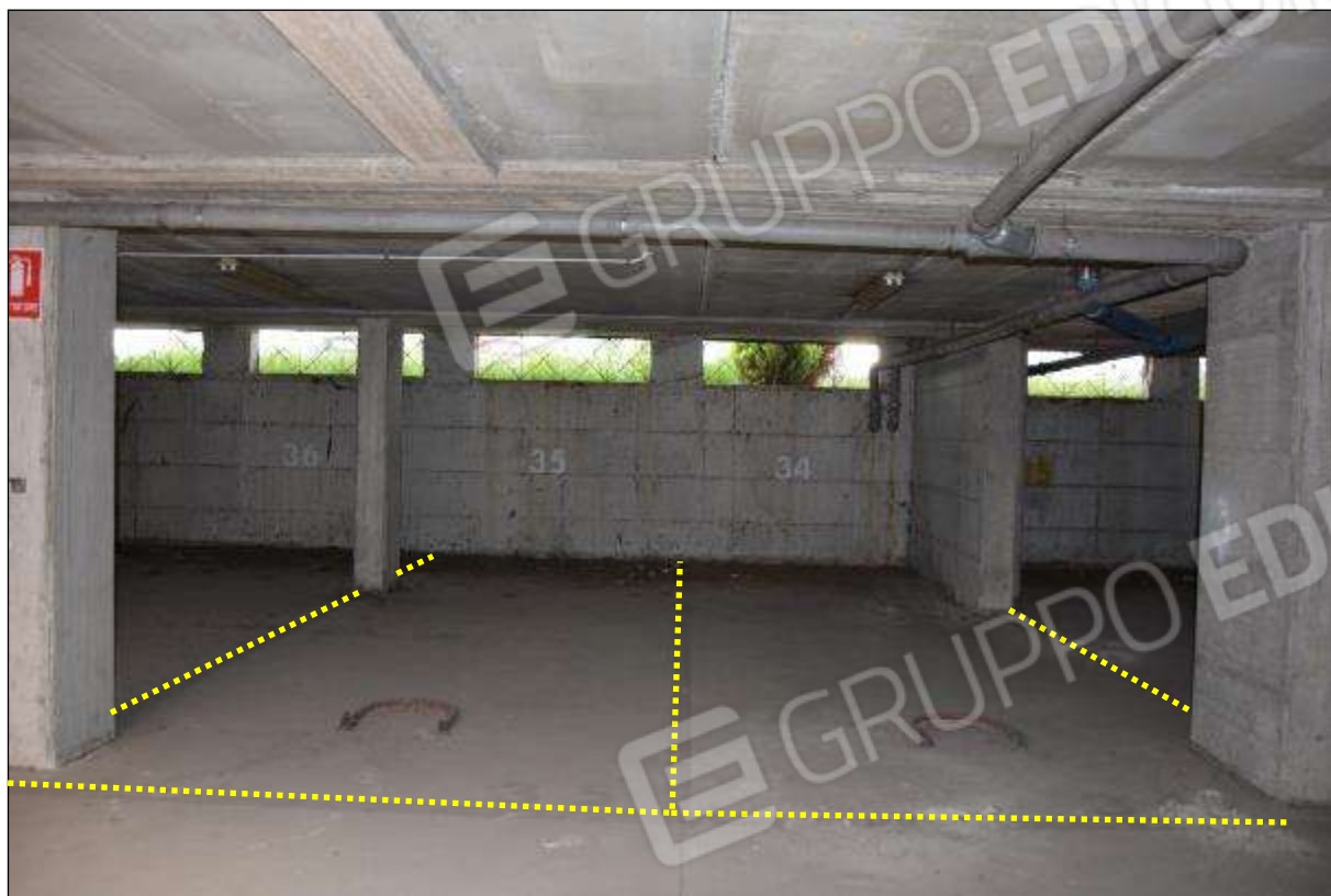
FOTO 3 – SUB 115 (POSTO 35) – SUB 116 (POSTO 34)
