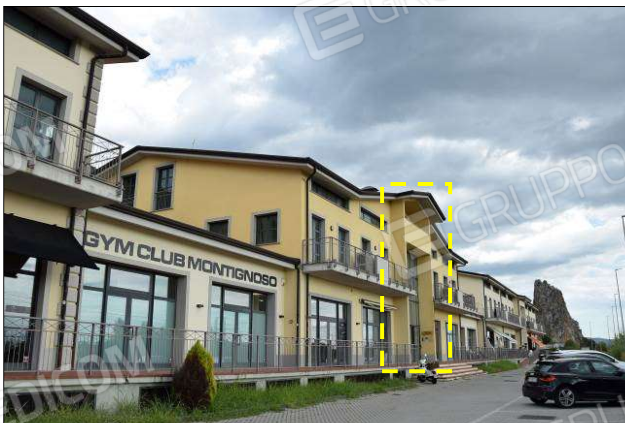
INDIVIDUAZIONE ACCESSO VANO SCALA “B” (BLOCCO CENTRALE)
