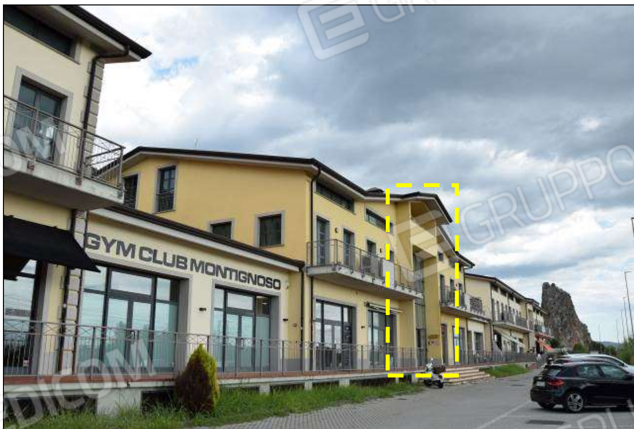
INDIVIDUAZIONE ACCESSO VANO SCALA “B” (BLOCCO CENTRALE)
