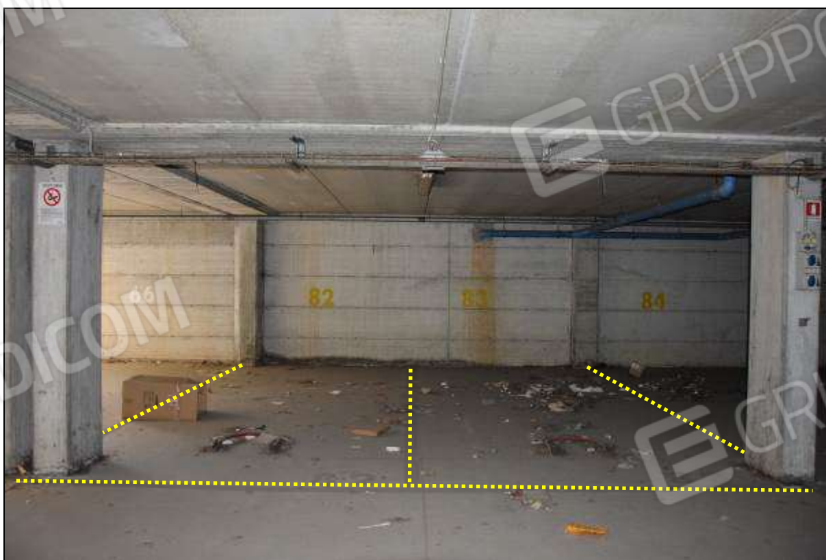
FOTO 2 – SUB 69 (POSTO 82) / SUB 70 (POSTO 83)
