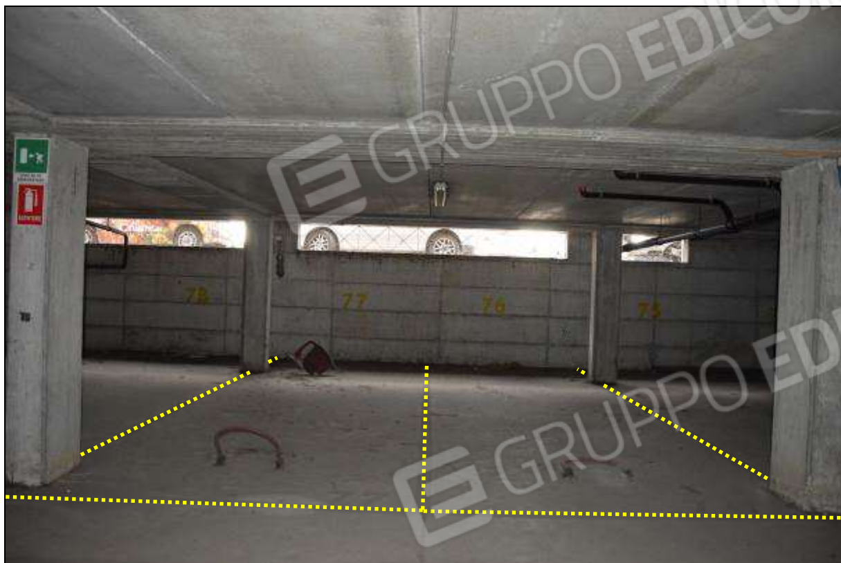
FOTO 1 – SUB 91 (POSTO 77) / SUB 92 (POSTO 76)
