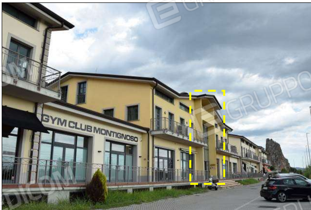
INDIVIDUAZIONE ACCESSO VANO SCALA “B” (BLOCCO CENTRALE)
