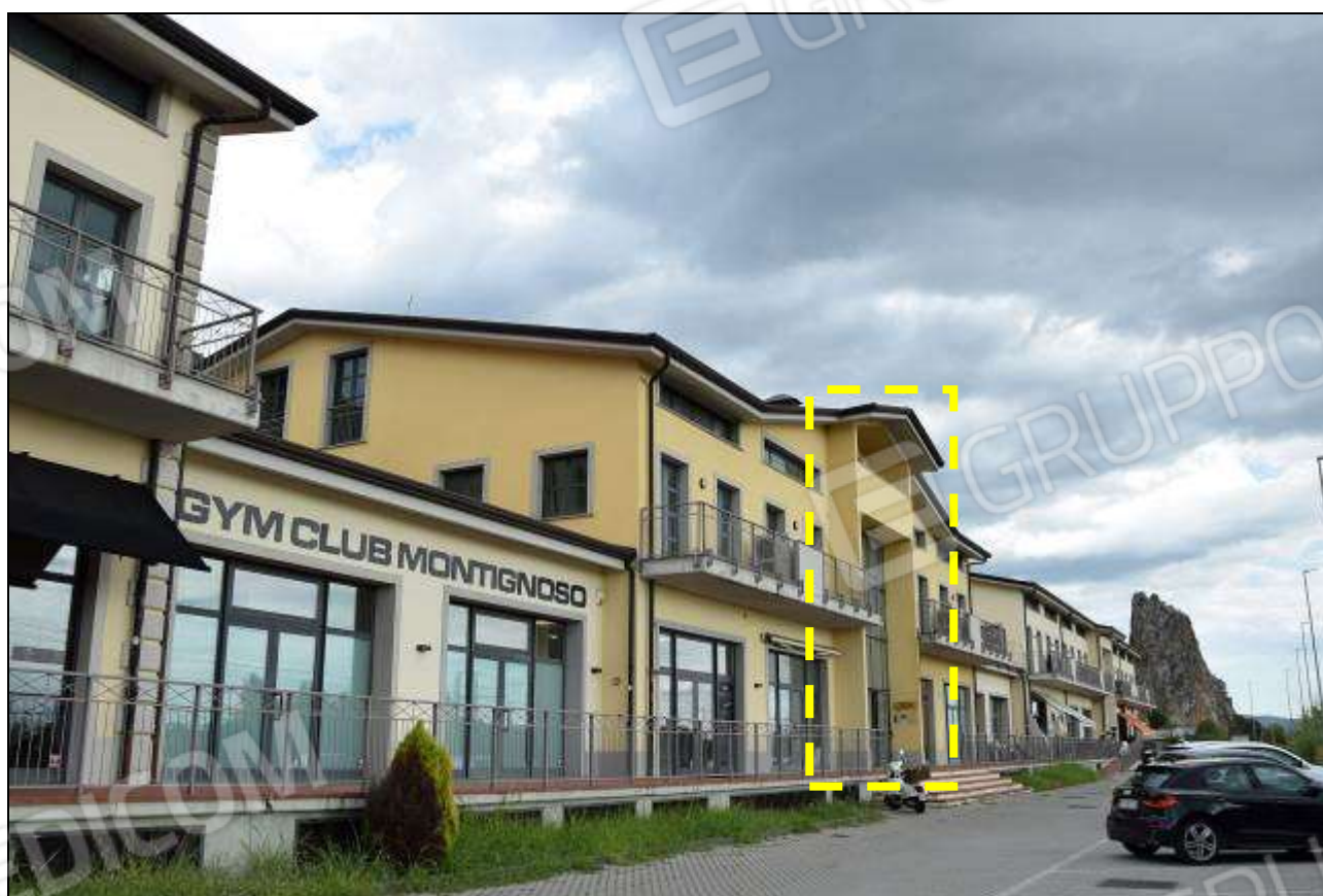
INDIVIDUAZIONE ACCESSO VANO SCALA “B” (BLOCCO CENTRALE)
