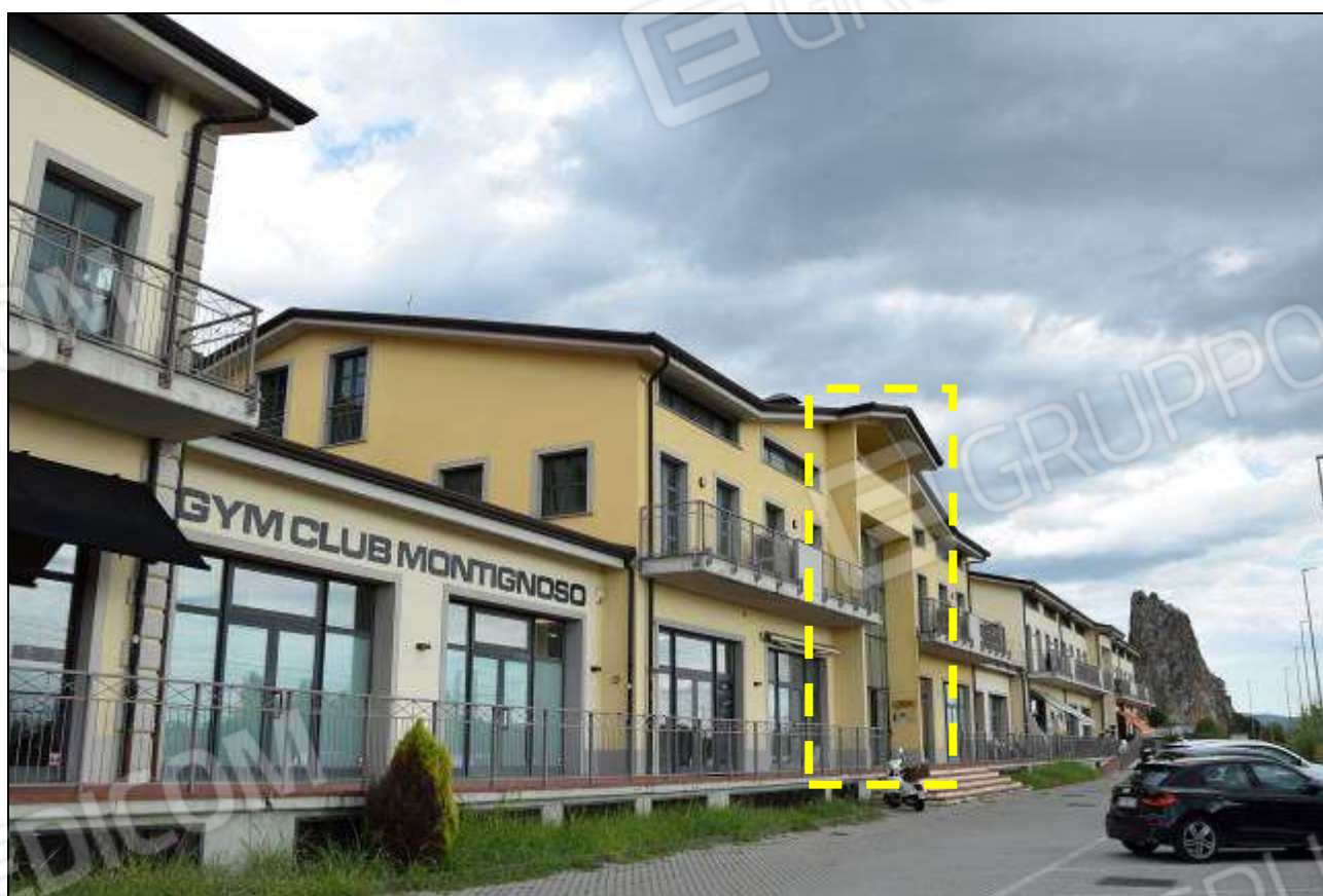
INDIVIDUAZIONE ACCESSO VANO SCALA “B” (BLOCCO CENTRALE)
