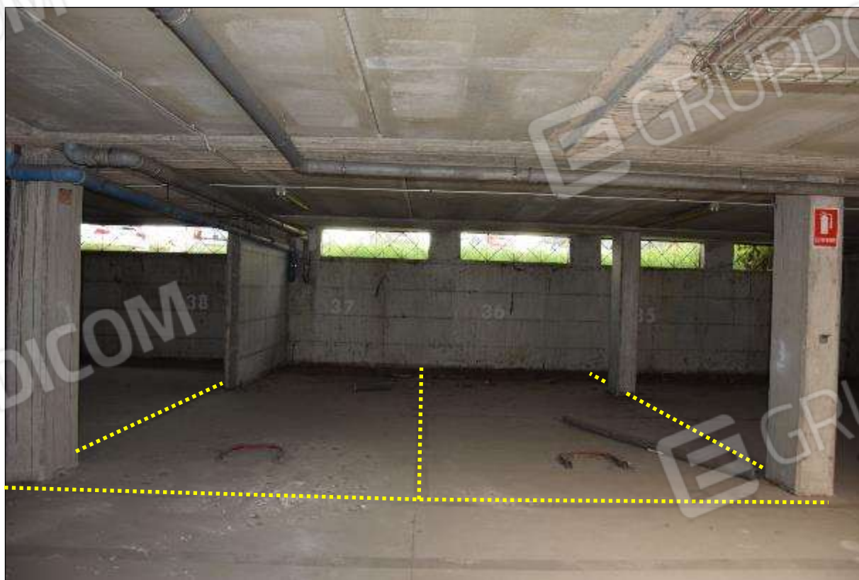
FOTO 2 – SUB 113 (POSTO 37) – SUB 114 (POSTO 36)
