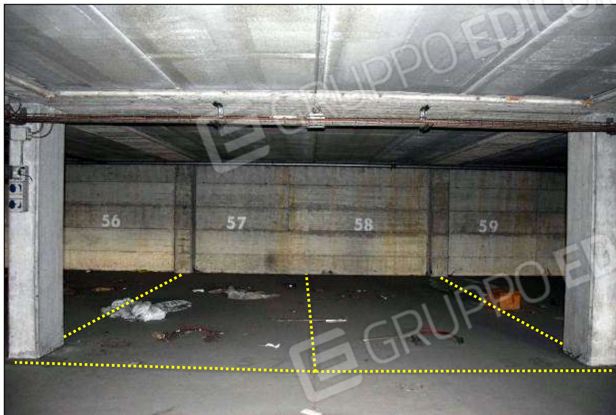
FOTO 1 – SUB 61 (POSTO 57) / SUB 62 (POSTO 58)
