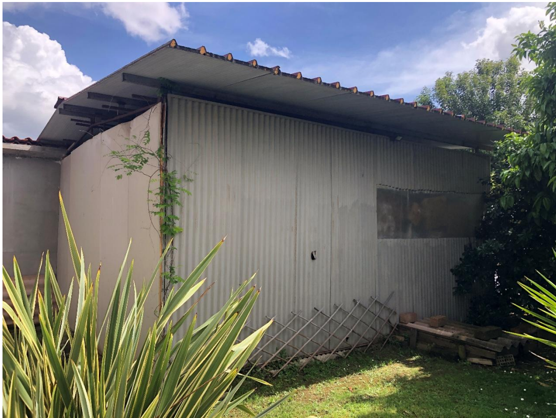
Figura 31 – Manufatto di pertinenza da rimuovere
