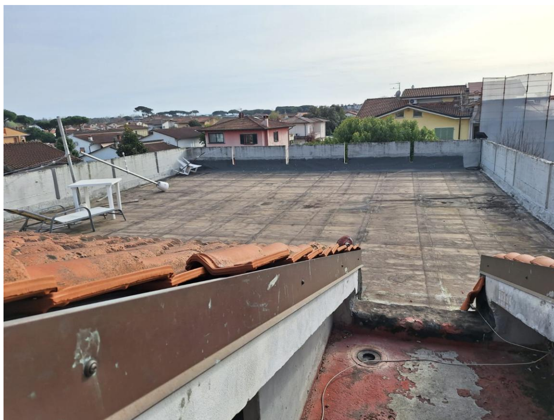
Figura 34 – Copertura piana al piano secondo
