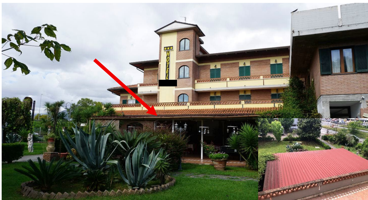
Figura 19 – Tettoia da rimuovere
