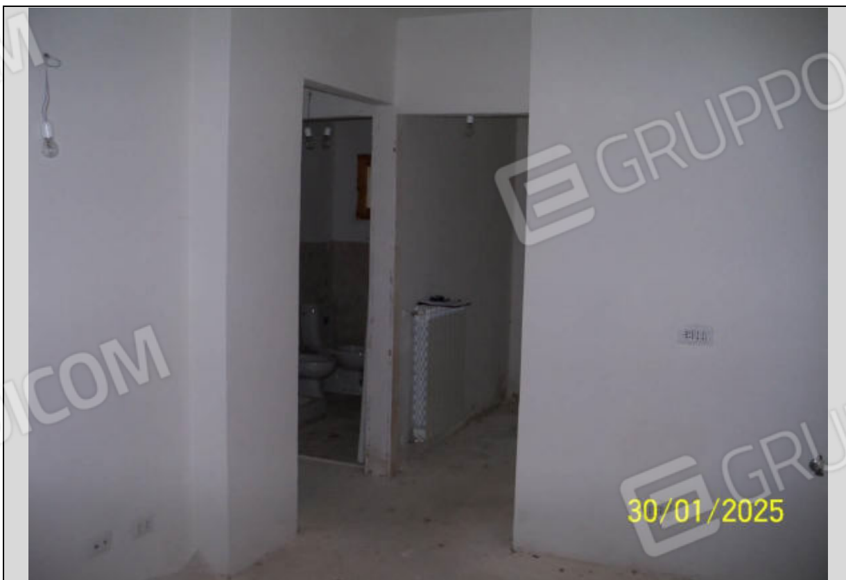
Vista Interna: Zona disimpegno vista dal locale ingresso-soggiorno Si nota l'assenza completa della pavimentazione, delle porte interne e finiture
