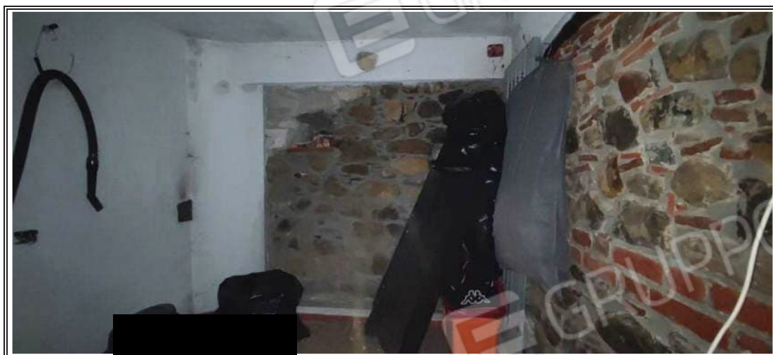
Foto n. 14 – Piano terra - Cantina
