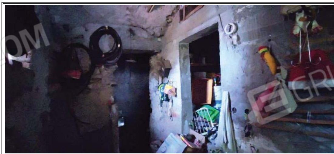
Foto n. 12 – Piano terra - Cantina
