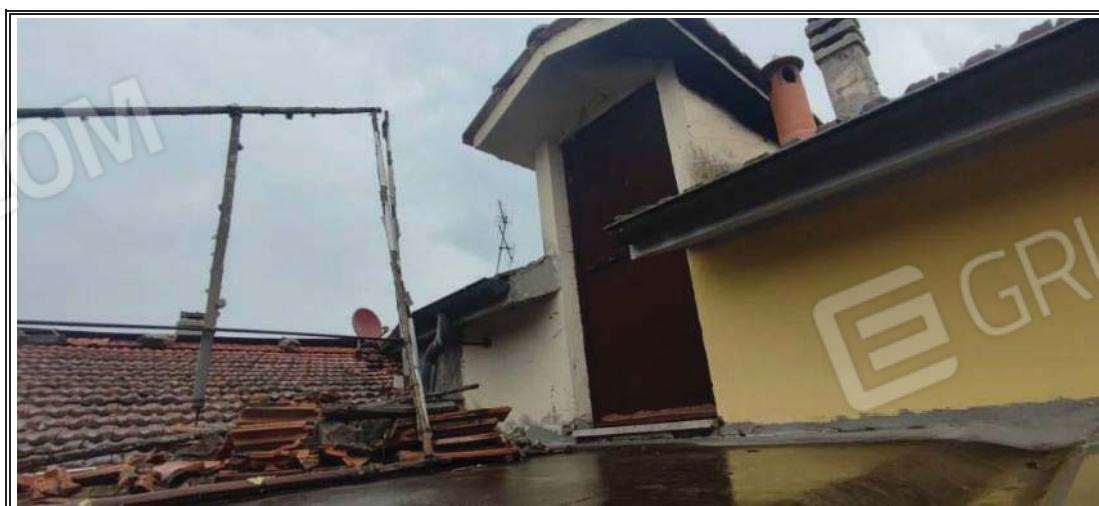
Foto n. 3 – Vista fabbricato – Ingresso ai vani sottotetto
