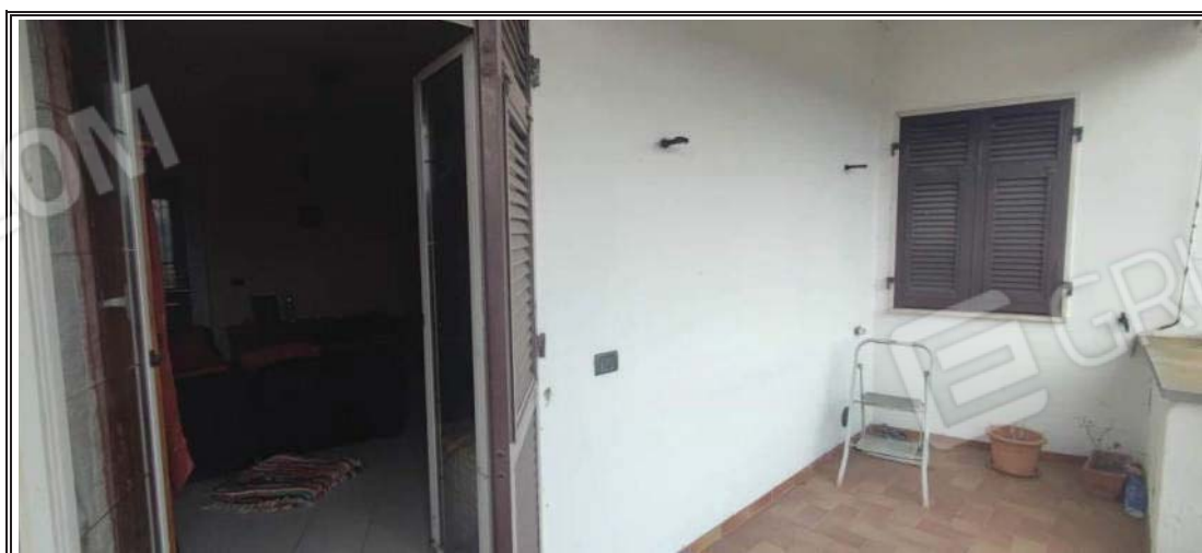
Foto n. 9 – Piano primo - Loggia
