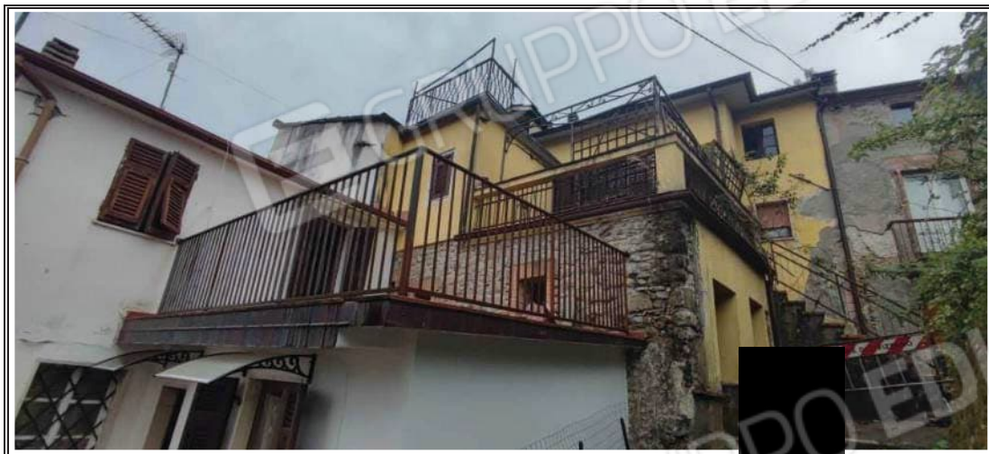
Foto n. 1 – Vista del fabbricato - angolo SUD/OVEST
