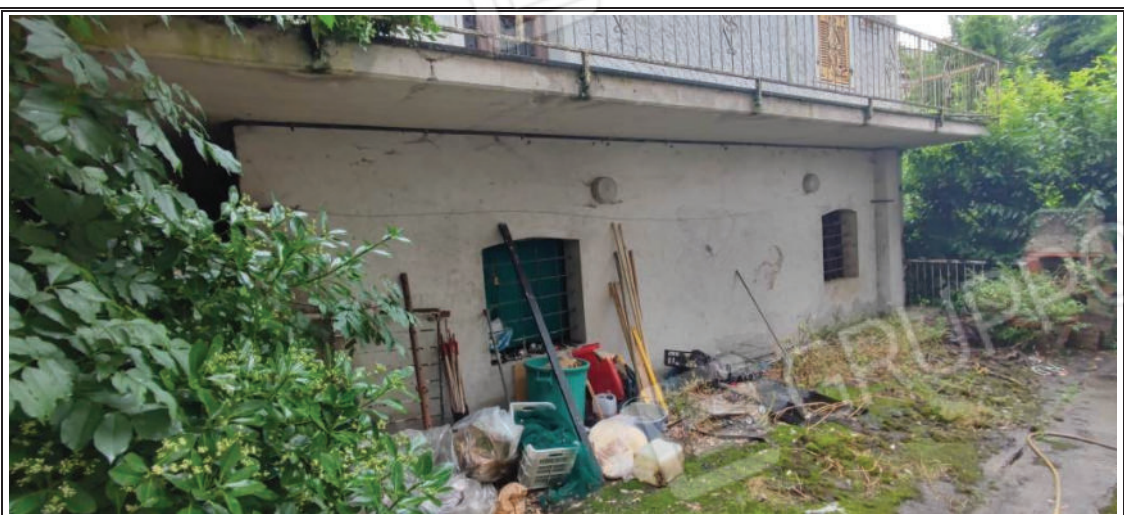
Foto n. 5 – Vista del fabbricato - Facciata lato OVEST
