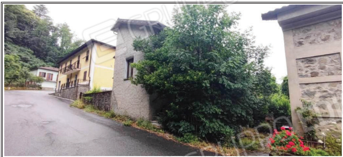
Foto n. 1 – Vista del fabbricato angolo NORD/OVEST
