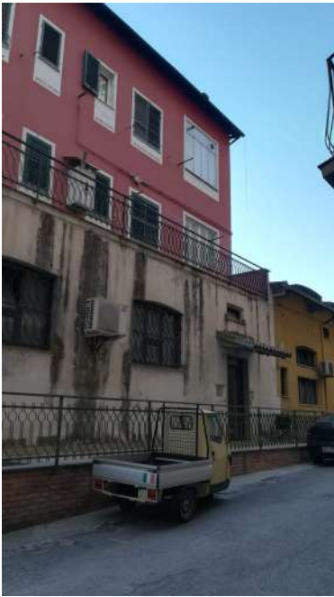
Foto n. 04-06: vista del prospetto principale dalla sede stradale - Via del Serra.
