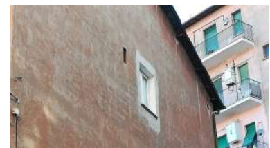
Dettaglio: stato conservativo delle facciate e dello sporto di gronda/copertura.
