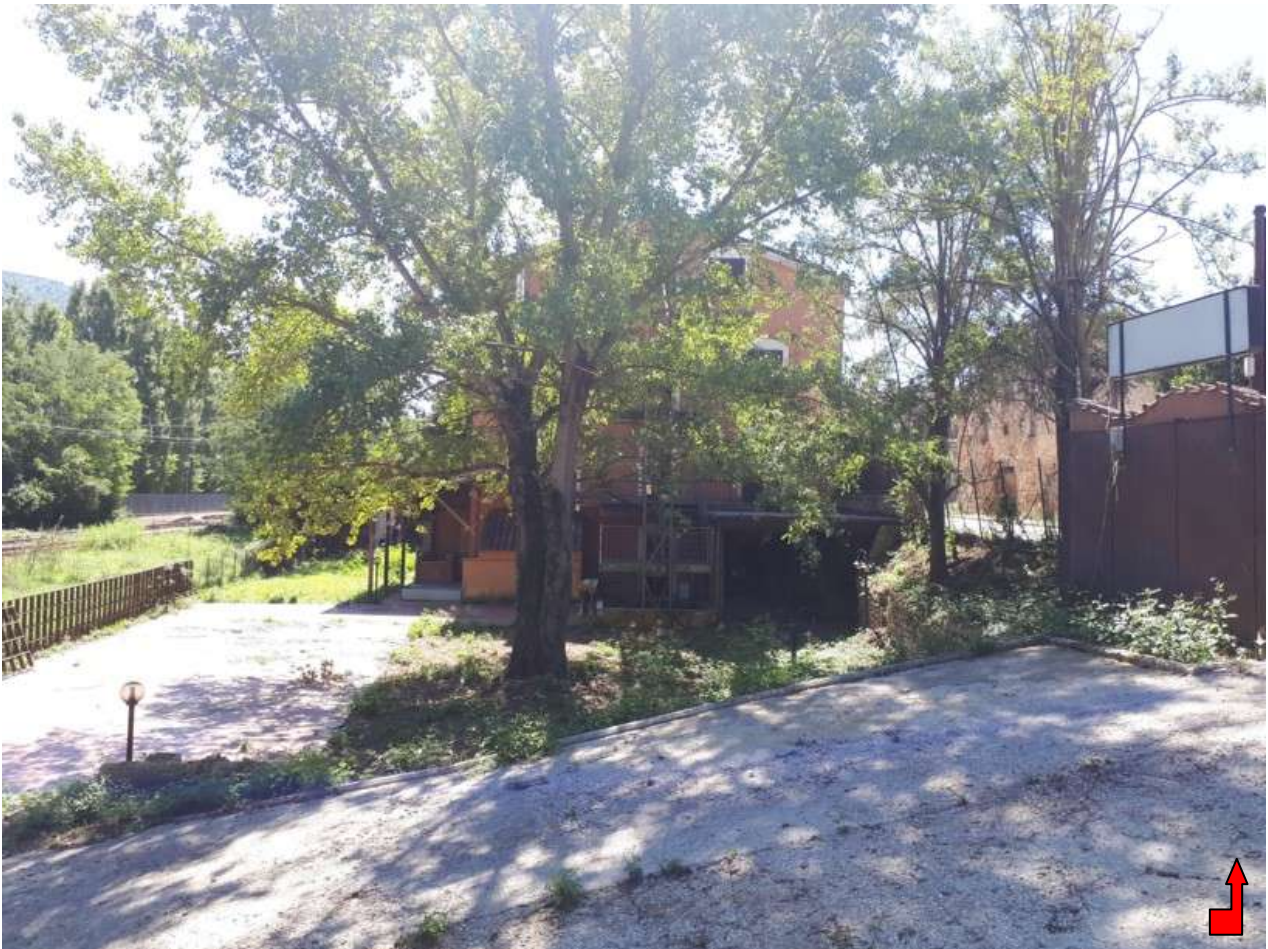
(FABBRICATO e TERRENO - vista esterna)
