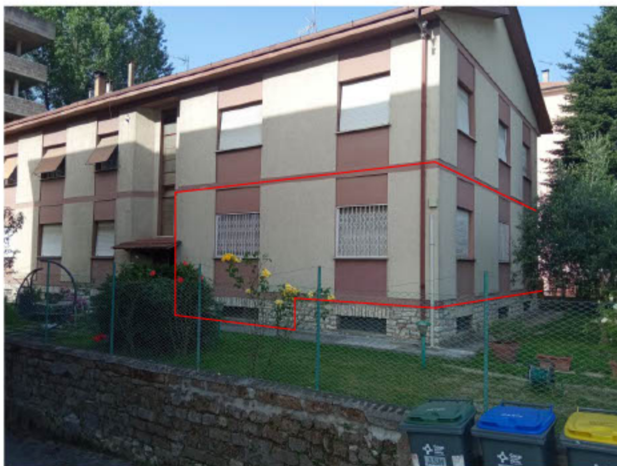
2 – ESTERNO – Angolo prospetti est e nord – Sub 3
