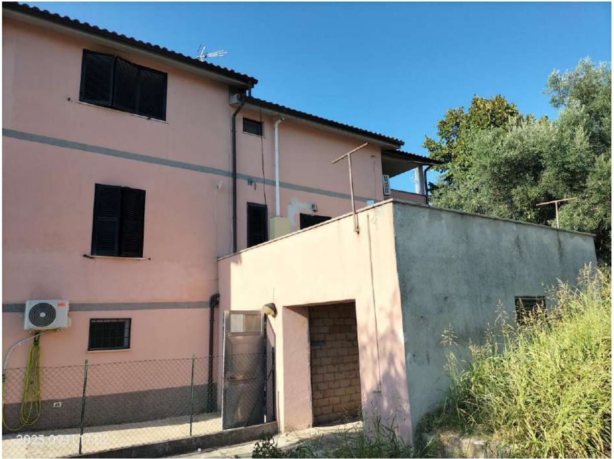
esterno fabbricato - lato sud con vista locale garage/rimessa (corpo B della perizia)
