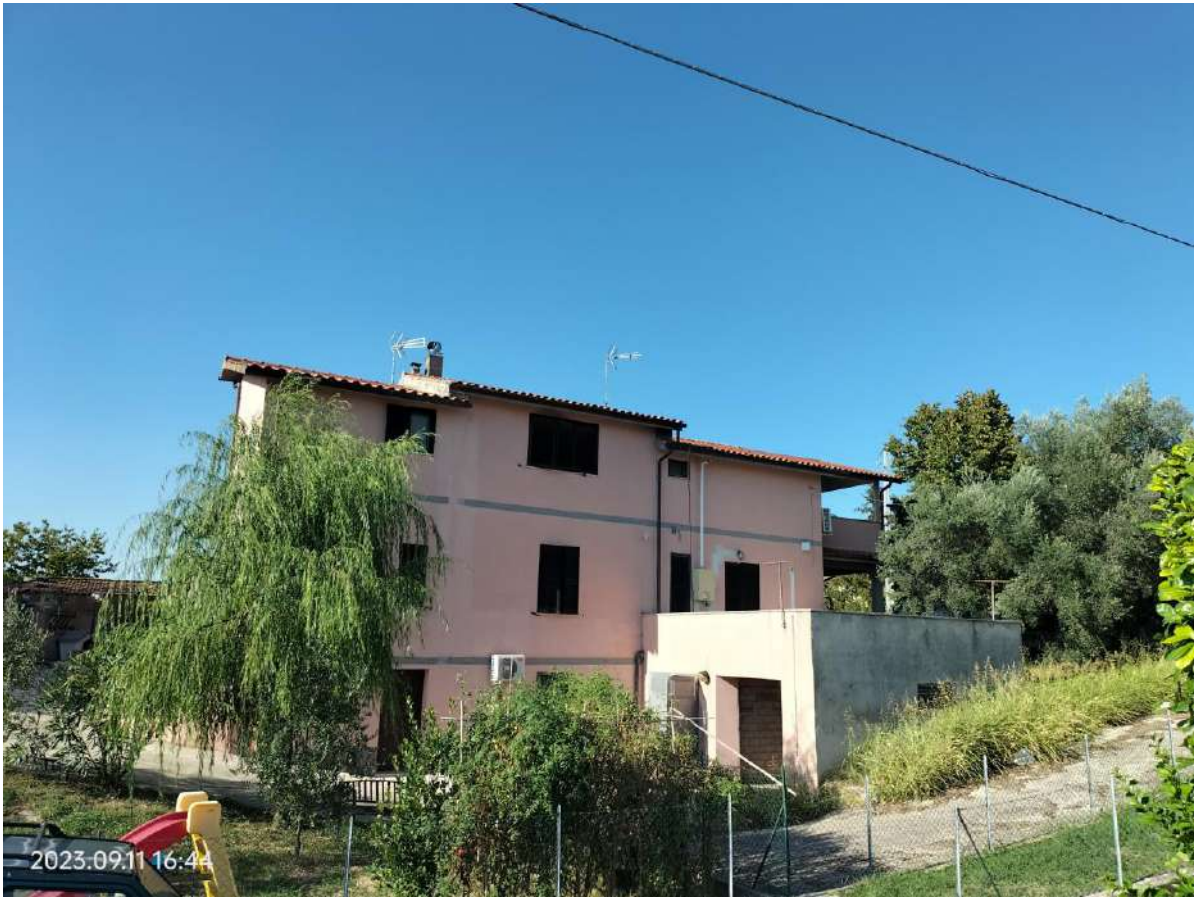
esterno fabbricato - lato sud
