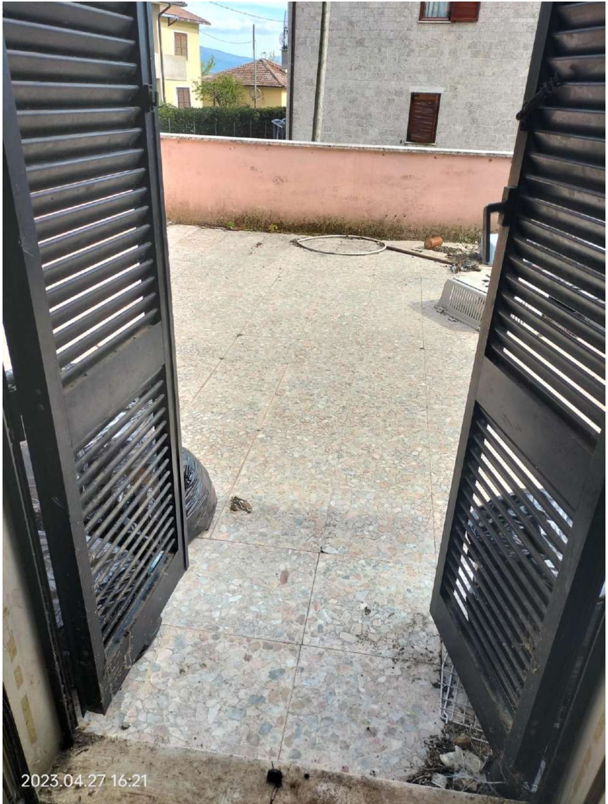
vista terrazzo esterno con accesso dal vano cucina
