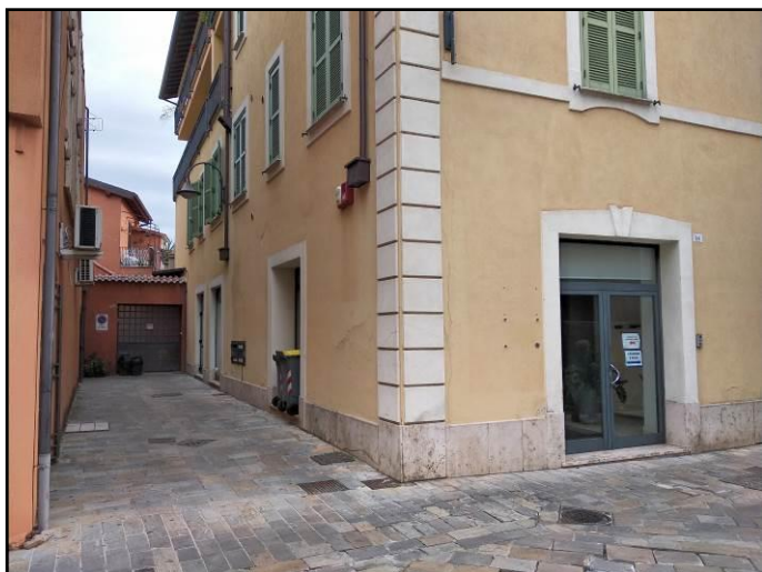
Vista esterna – vicolo lato NW
