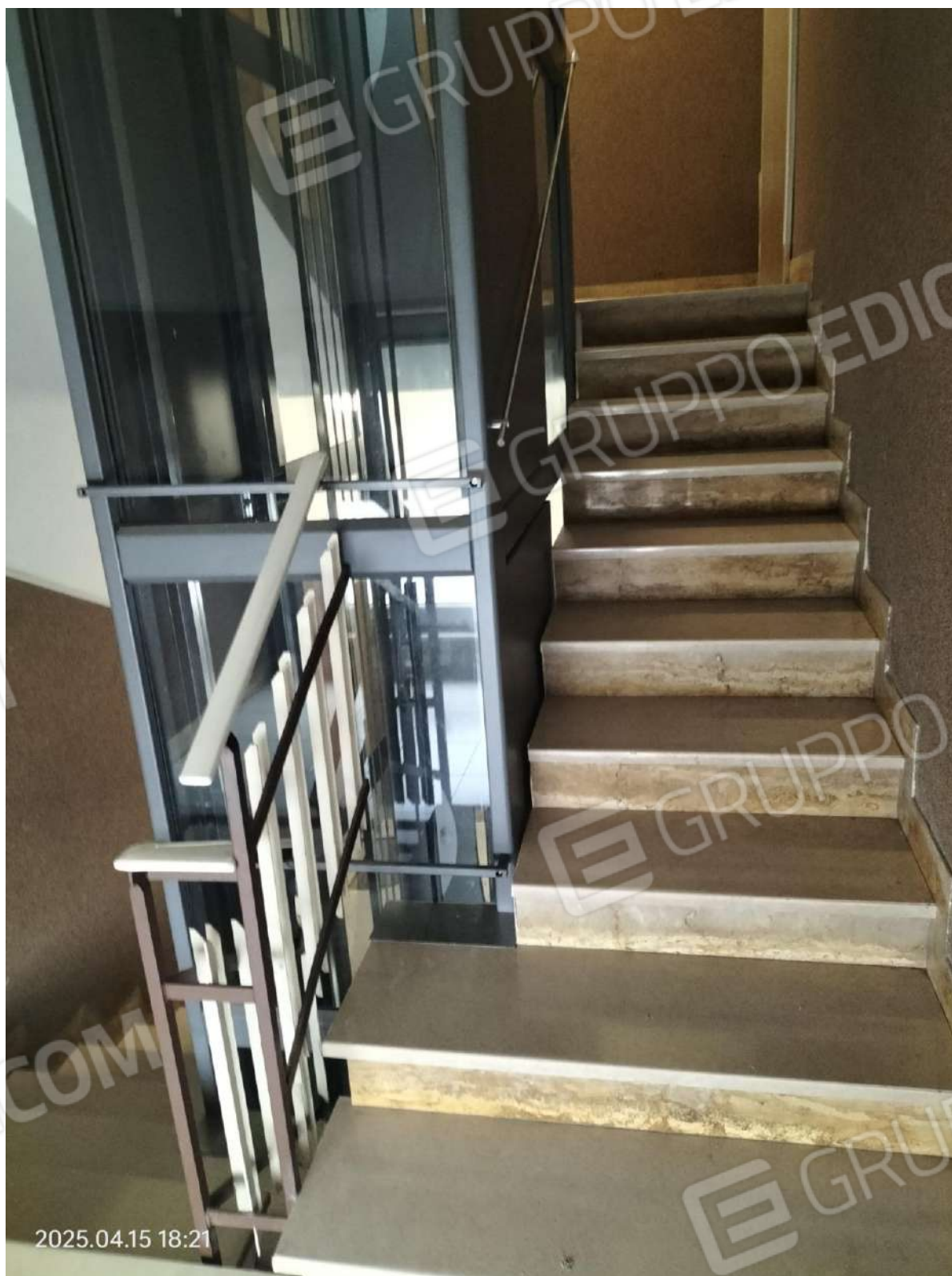
interno fabbricato - vano scala con vista ascensore
