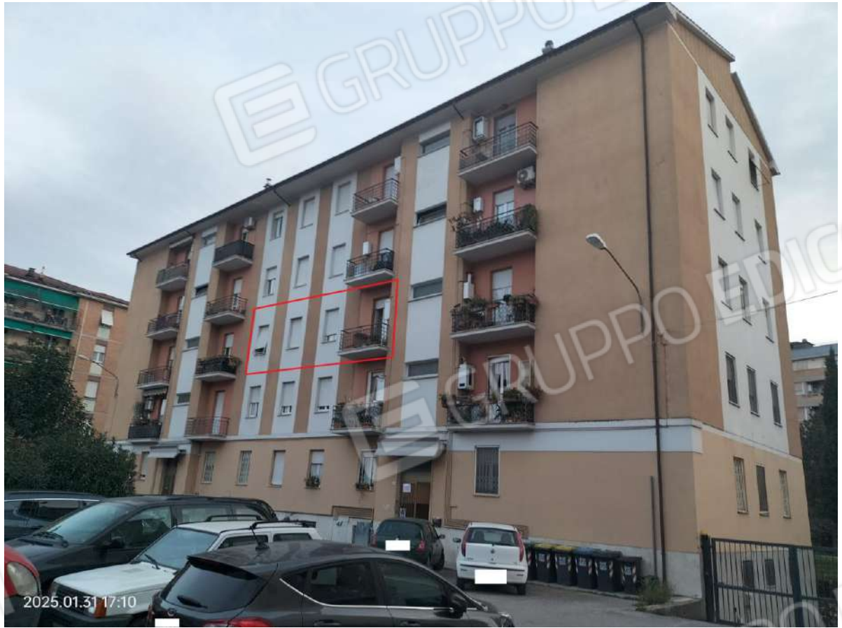
esterno fabbricato - vista lato nord/ovest
