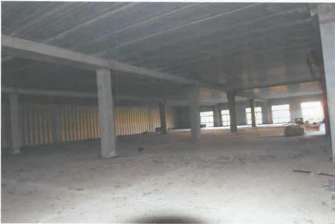
13) Viste interne piano terra;
