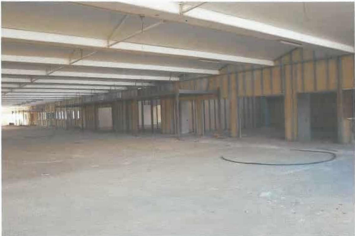
27) Vista interna piano primo;
