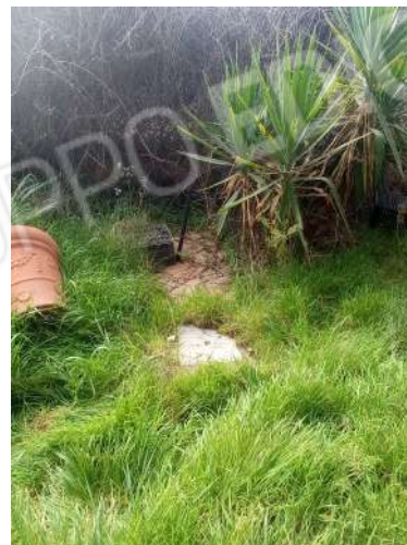
Foto n. 16: dettaglio della Fossa settica interrata nel giardino.
