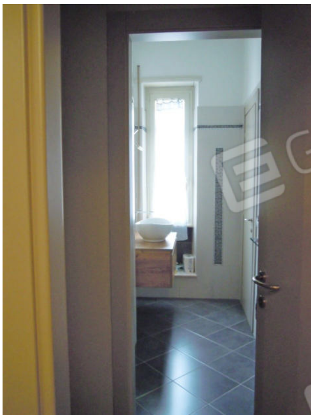
Foto 07 – il bagno 1 dalla porta d'accesso
