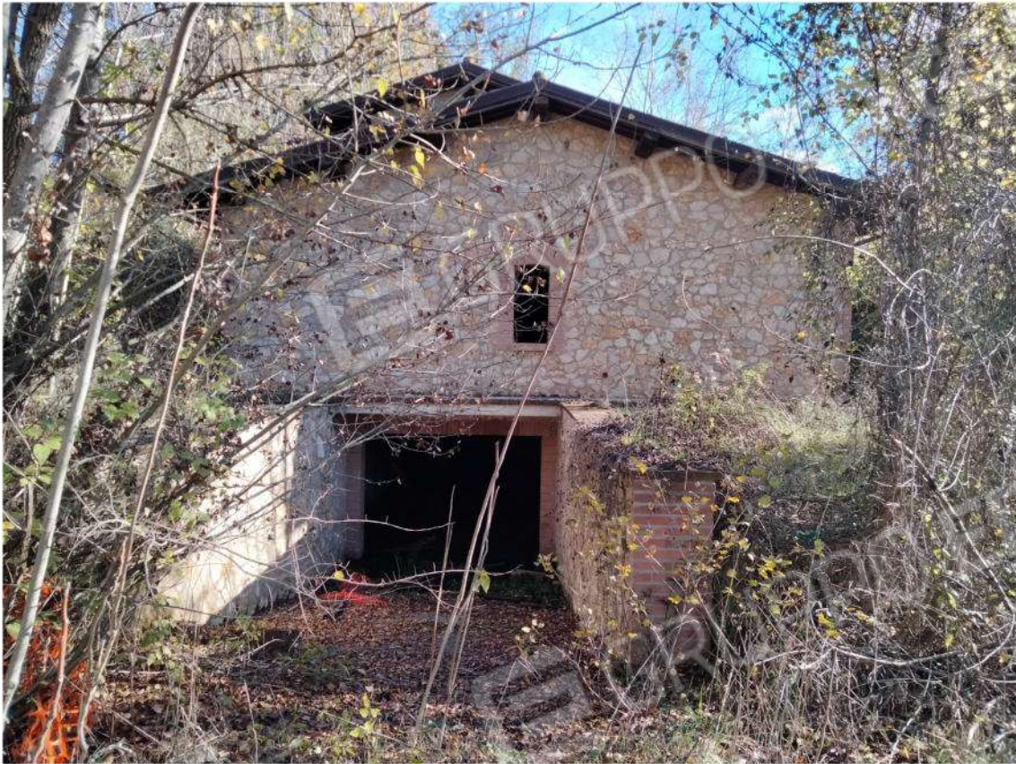
FOTO N. 9 - RAMPA DI ACCESSO AL PIANO INTERRATO
