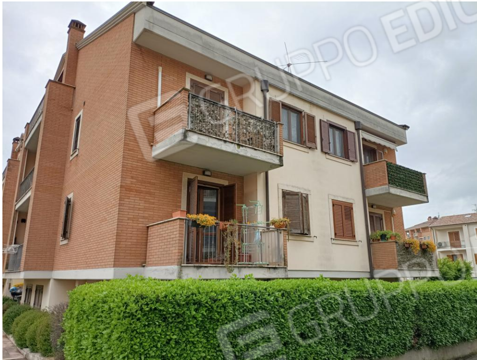
Fotogramma n. 5 Prospetto Lato Nord
