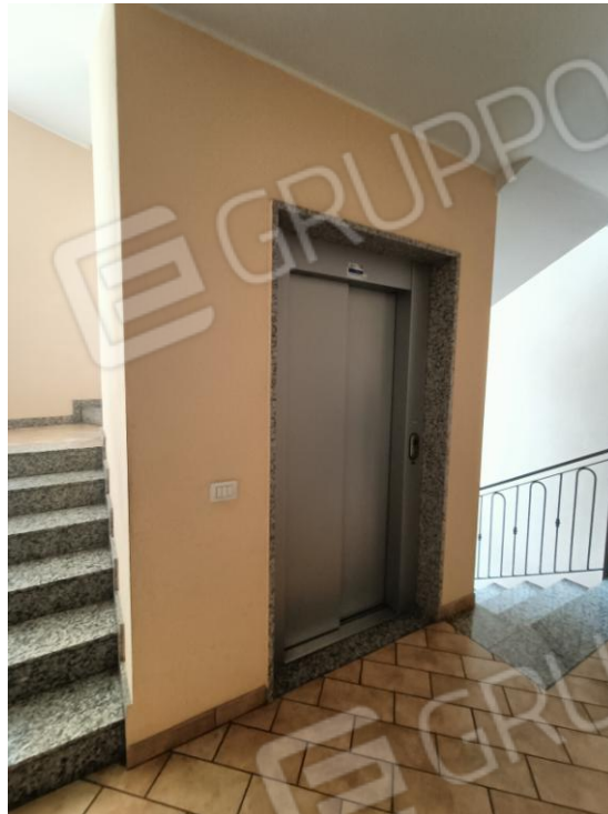
Fotogramma n. 13 Ascensore Condominiale
