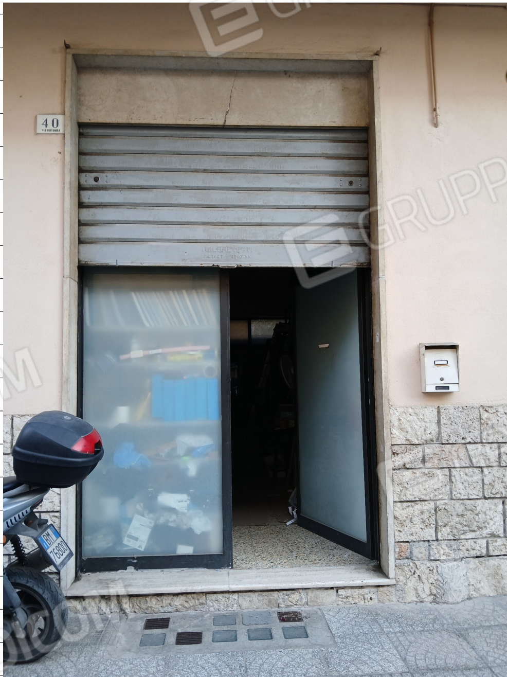
Ingresso dal numero civico 40 di via Montanara
