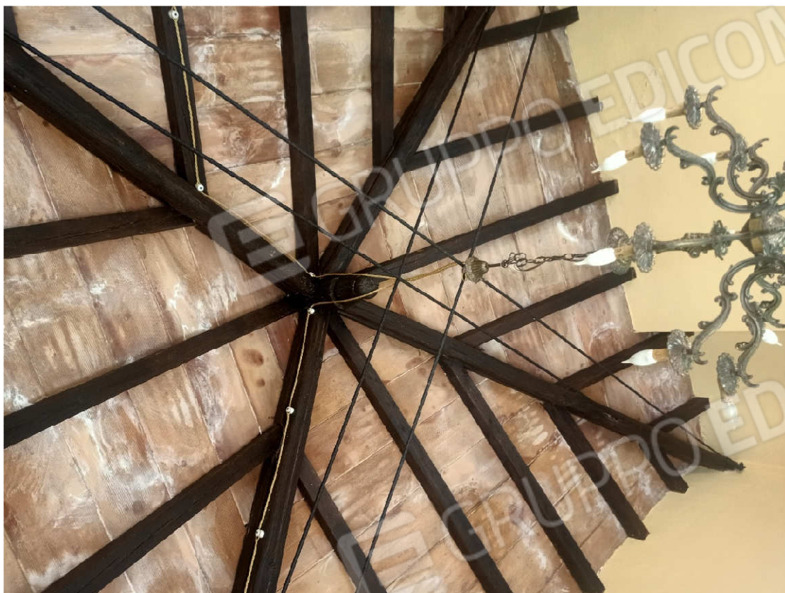
Particolare copertura altana
