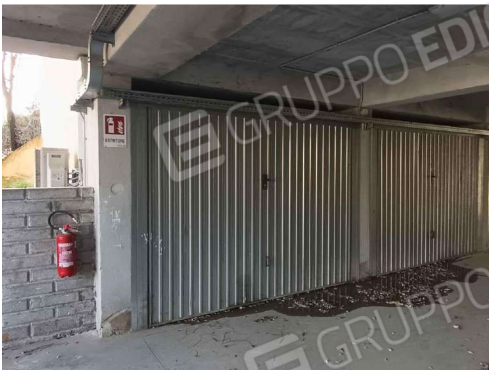
13 – Visione Ingresso Autorimessa – P. interrato - (sub. 24)
