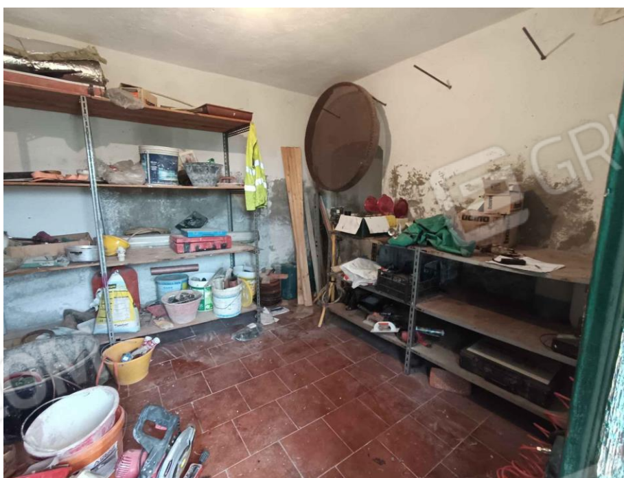
Locale accessorio 1 – PT (Cellaio)
