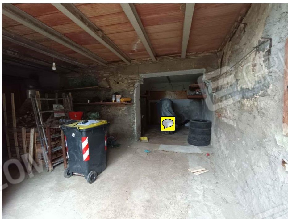
Locale accessorio 2 – PT (Autorimessa)
