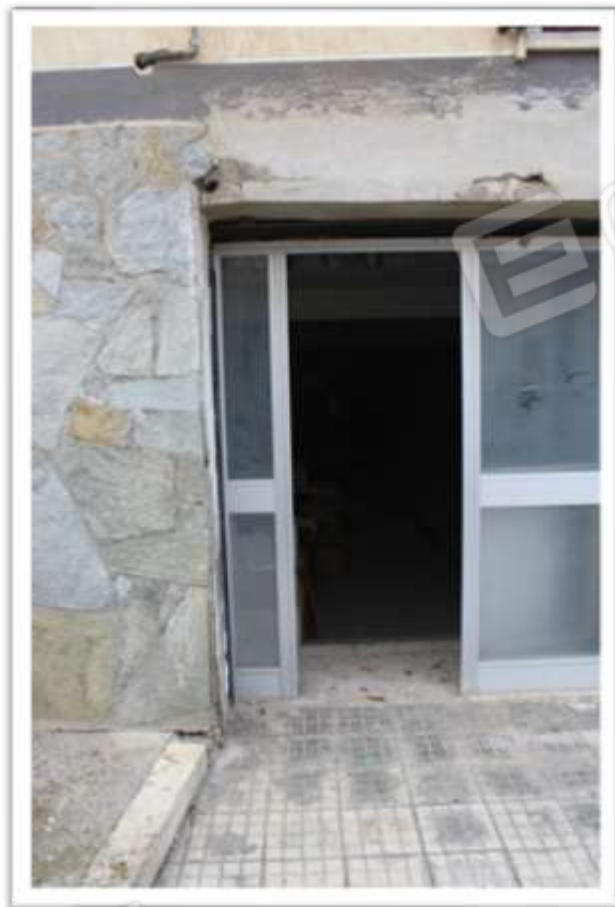
FOTO 2 – PORTA DI ACCESSO
