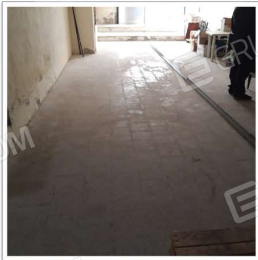
FOTO 12 – PAVIMENTAZIONE DEL DEPOSITO IN GRANIGLIA DI MARMO
