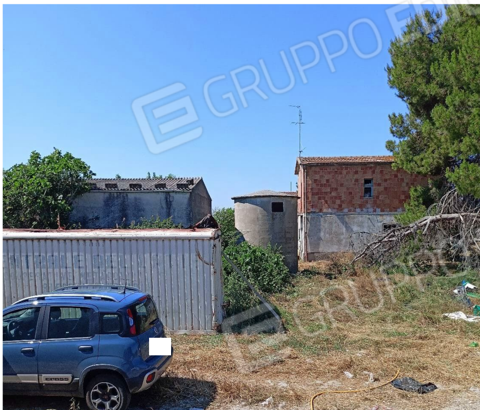
Deposito in muratura di tufo
