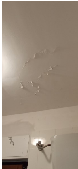
Particolare solaio bagno
