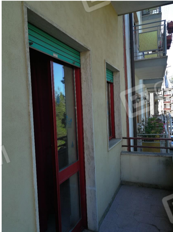
Piano primo – balcone su strada principale
