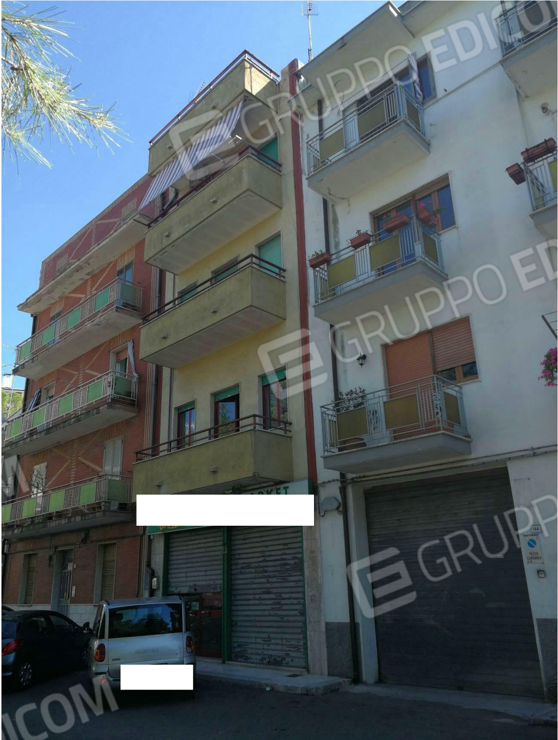
Prospetto su strada principale con edifici adiacenti
