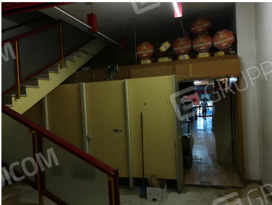
Ingresso dal negozio al vano scala
