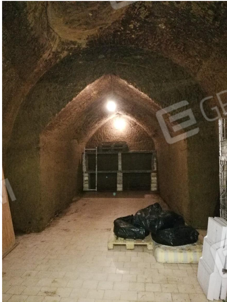
Ambiente interno a piano terra della cantina retrostante , ricavata nella calcarenite
