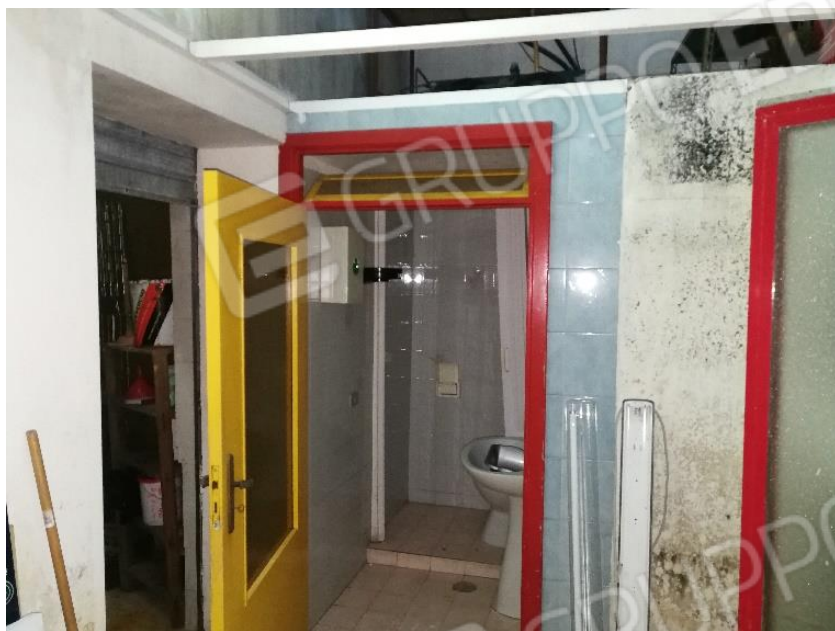
Bagno presente nel vano di separazione tra scala e cantina
