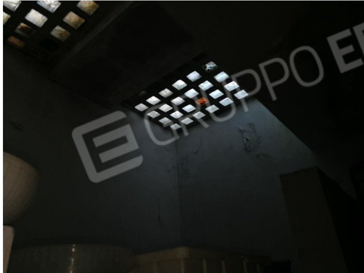
Solaio in vetro cemento su vano di separazione con cantina al piano terra
